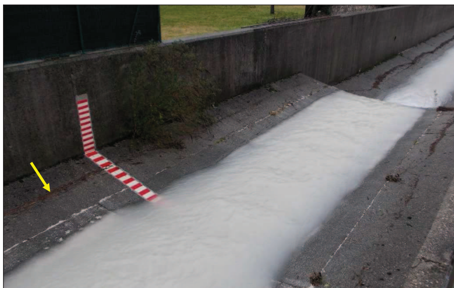
Figura 5.20: Particolare relativo al deposito di materiale in sospensione presso la Sezione 12 (T. Vegliato) in occasione dell'evento meteorico del 04-05 gennaio 2014.
