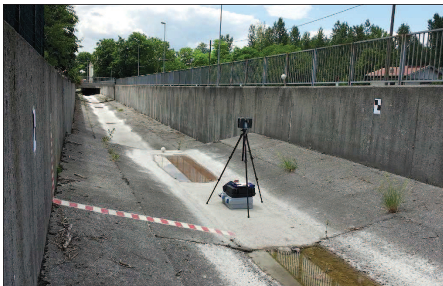
Figura 5.19: Rilievo con tecnologia laser scanner della Sezione 12 (T. Vegliato).
