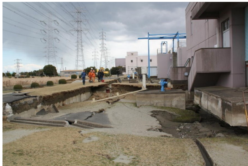
Fig. 5.14: Effetti di liquefazione avvenuti a seguito del terremoto di Tohoku.
