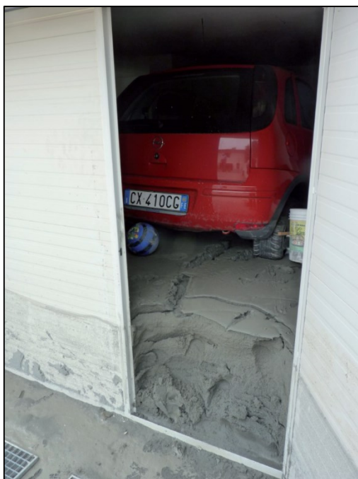
Fig. 5.16: Fessurazioni del terreno con espulsioni di sabbia in località San Carlo (FE) a seguito dell'evento sismico del 2012 in Emilia.
