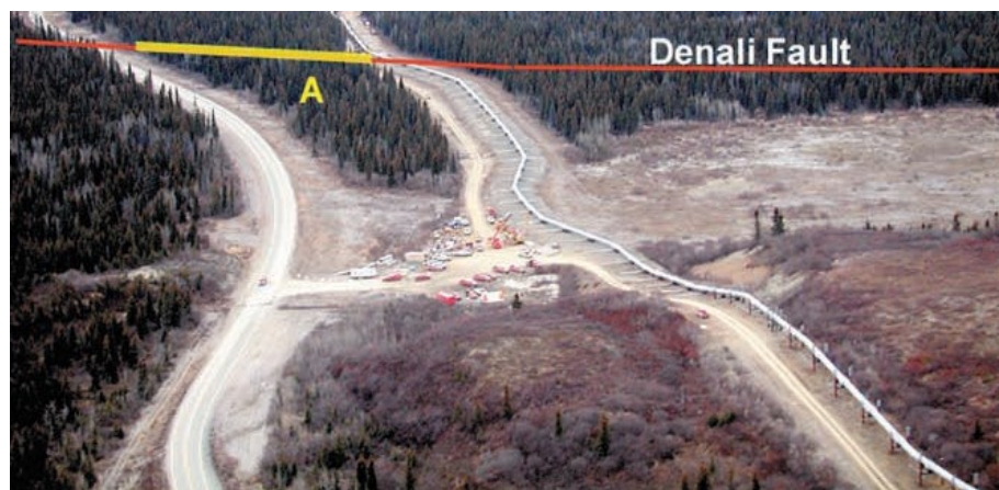
Fig. 5.3: Tracciato della faglia Denali in corrispondenza dell'incrocio con la condotta del TAP. Il tratto della linea evidenziata in giallo e con la lettera A localizza la zona in cui si sono verificati danni agli alberi lungo la faglia (vedi Fig. 5.5).
