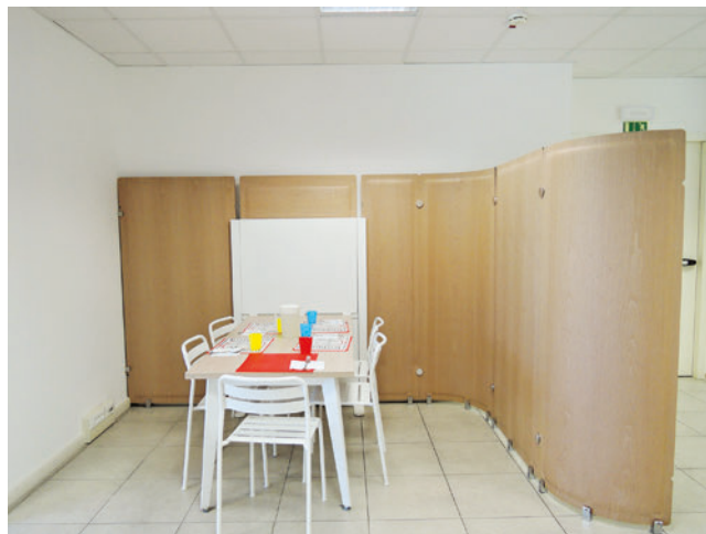
Fig.02 Progettoautismo FVG, mensa, primo piano: elementi divisori curvilinei fonoassorbenti ancorati a pavimento che definiscono le aree destinate al pranzo di piccoli gruppi. Foto delle autrici
