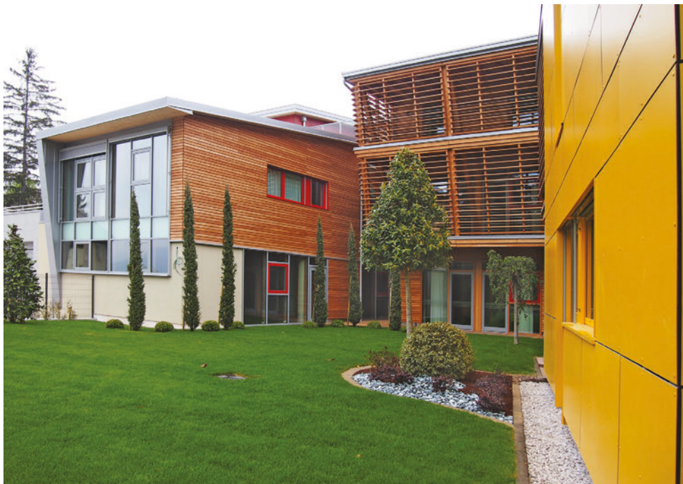
Fig.01 Casa Sebastiano (Coredo, TN): vista dal cortile interno.
