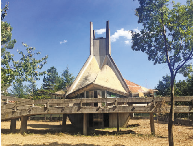
Fig.02 Vista dell'attuale stato in cui versa l'ingresso del complesso.
