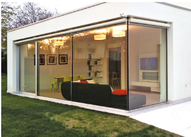
Fig.04 Villa Le Rogge (Pordenone): vista dello spazio soggiorno dall'esterno.
