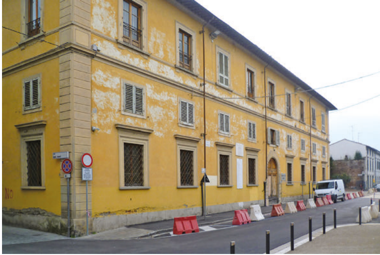
Fig.04 Il complesso architettonico di Piazza XXIV Luglio prima dell'intervento di ristrutturazione.
