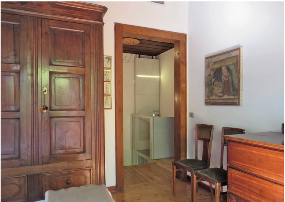
Fig.04 Piattaforma elevatrice: al secondo piano, le pareti in cristallo del vano corsa si interrompono in corrispondenza del parapetto della scala.
