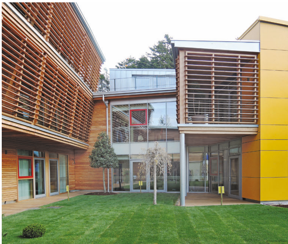
Fig.03 Casa Sebastiano, veduta della corte interna: alternanza fra gli elementi vetrati e i frangisole lignei che schermano i terrazzi. Foto delle autrici
