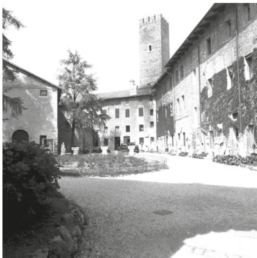
Fig.02 Giardino del Teatro Olimpico, stato di fatto. La ghiaia impiegata per la pavimentazione e i gradini in corrispondenza degli ingressi rappresentano un ostacolo per le persone che utilizzano la sedia a ruote, per i passeggeri, per gli anziani con difficoltà a deambulare.
