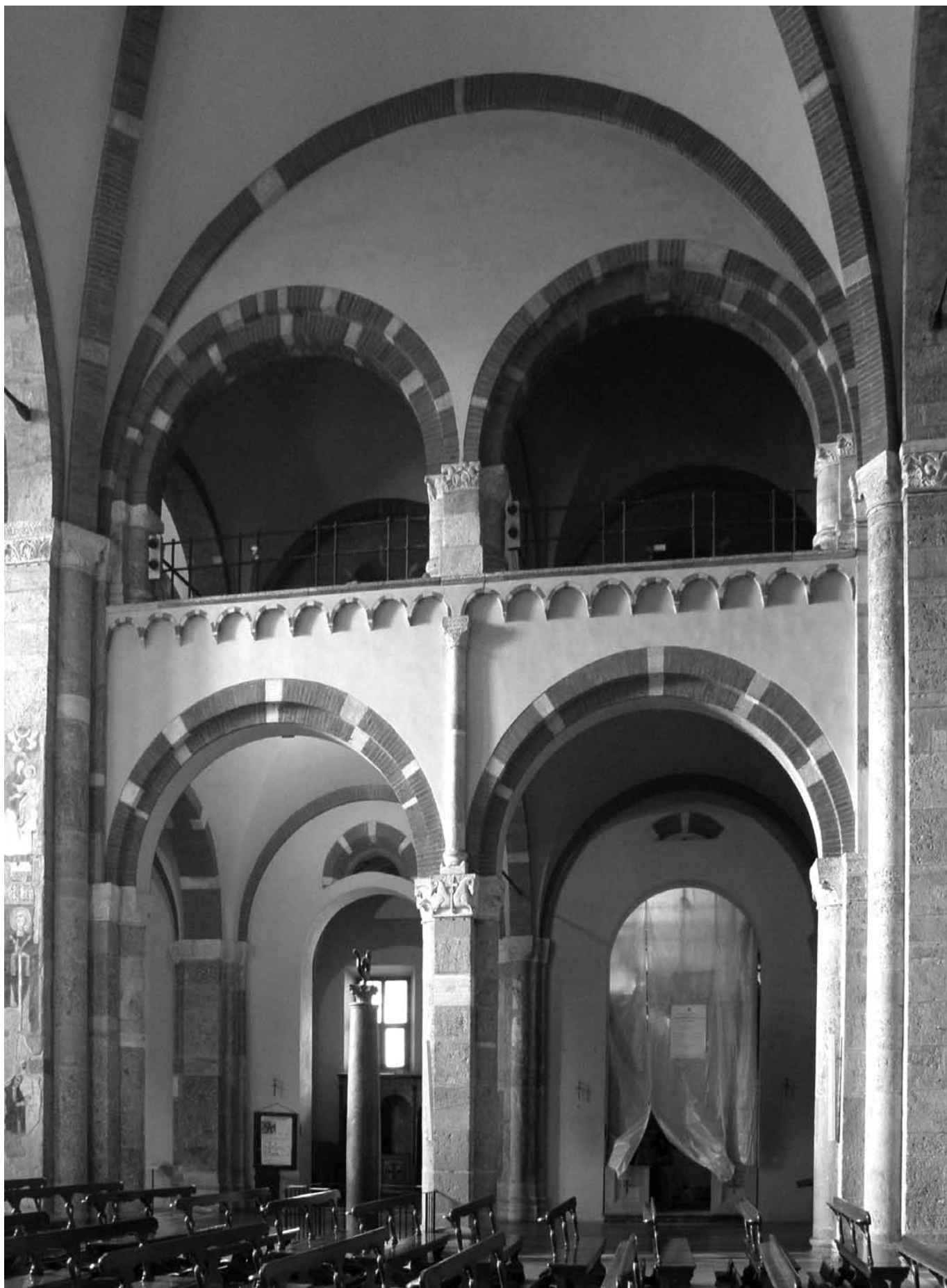
32. Milano, Sant'Ambrogio, veduta di una campata della parete nord della navata centrale.
