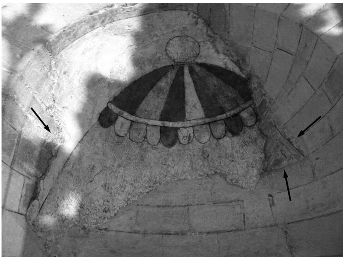
28. Verona, Santa Maria Antica, nicchia meridionale dell'abside maggiore: si noti, indicata dalle frecce, la disposizione a spina-pesce dei mattoni della calotta.
