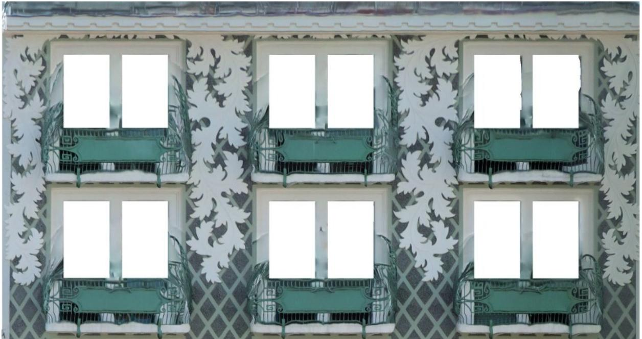
Dopo aver impostato la vista frontale ortogonale del modello finale, è stata avviata la procedura di orto-mosaicatura atta a riprodurre il prospetto di Casa Bartoli. Purtroppo, le sopracitate distorsioni dovute alle ringhiere hanno impedito l'uso integrale dell'elaborato fotogrammetrico, mentre l'immagine della mosaicatura ortogonale è risultata essere l'unico strumento utile per rilevare la decorazione a cascade di fogliame in stucco (fig. 7).
