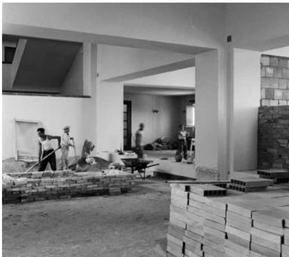
Fig. 6 Museo Archeologico Nazionale, Reggio Calabria. Le sale durante i lavori di demolizione e costruzione, 1948-1950 ca. (AFM; © Ministero della Cultura / Museo Archeologico Nazionale di Reggio Calabria).
