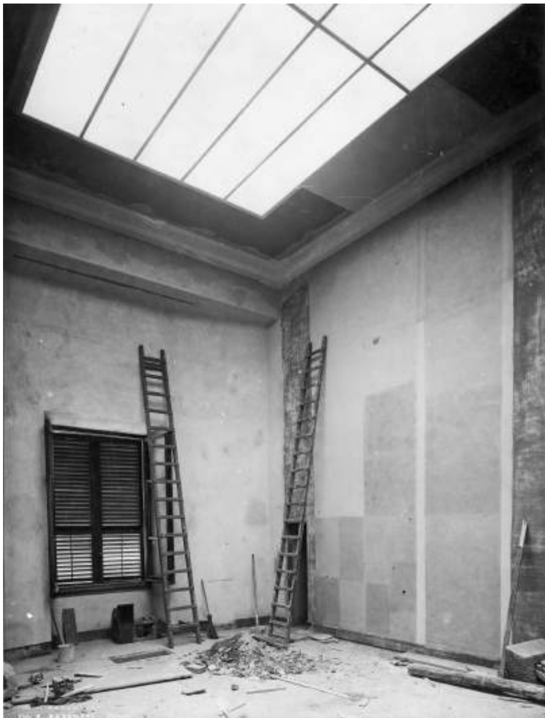
Fig. 15 Una sala della Galleria durante i lavori di rinnovamento strutturale, Galleria degli Uffizi, Firenze, 1953-1956. Stampa alla gelatina ai sali d'argento, timbro lineare "Foto F. Barsotti-Firenze" sul recto della stampa (Roma, ICCD, Archivio fotografico MPI, n. MPI319480; © Roma, ICCD).
