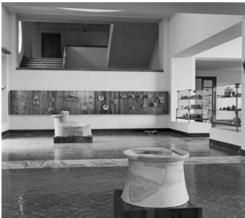
Fig. 5 Museo Archeologico Nazionale, Reggio Calabria. L'allestimento prima dei lavori di demolizione e costruzione, 1948 (AFM; © Ministero della Cultura / Museo Archeologico Nazionale di Reggio Calabria).
