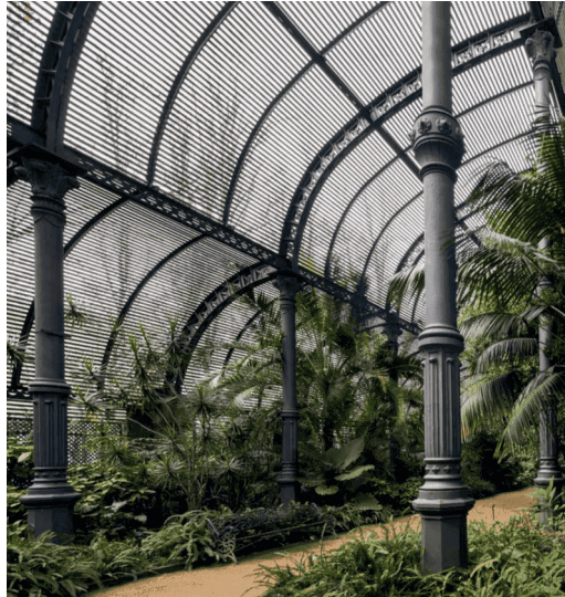
Figura 4 Ejemplo de estructura metálica característica de la arquitectura en hierro del siglo XIX: el Parc de la Ciutadella de Barcelona
