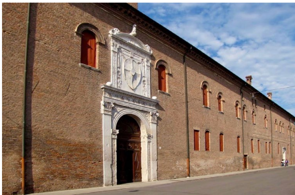
1: Il fronte esterno di palazzo Schifanoia con il portale monumentale sovrastato dal grande stemma estense con l'unicorno, impresa di Borso d'Este (foto di Giada Valente)
