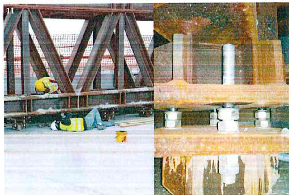
Fig. 9 - Montaggio travi basic NPS* appese. Fig. 10 - Trasporto trave reticolare. Fig. 11 - Sgancio del travi BasicNPS* dalla reticolare e relativo abbassamento
