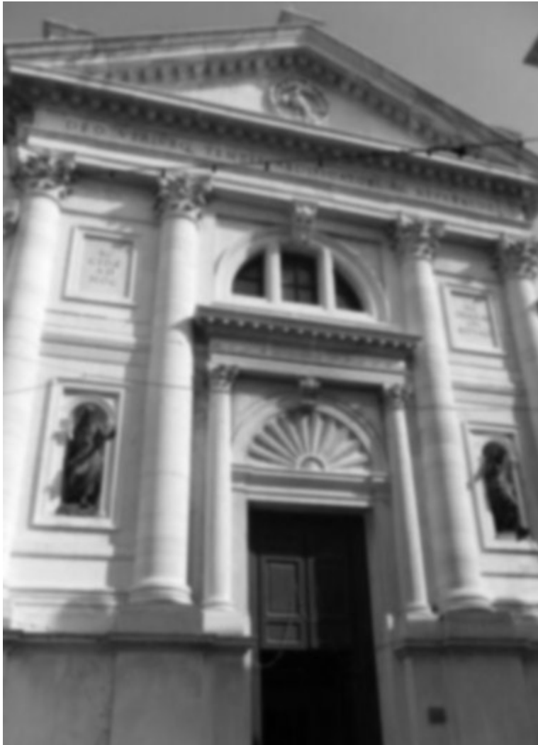
Figura 46. Facciata della chiesa di San Francesco della Vigna (su progetto di Andrea Palladio)
