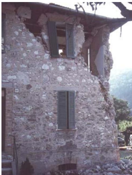
Fig. 5.25. Esempi di meccanismo di ribaltamento del cantonale: (a) foto da Zuccaro e Papa (2001); (b) immagine da Doglioni (2000).
