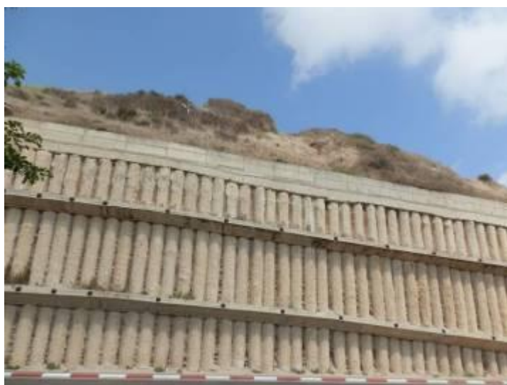
Tel Michal, 2012: sostruzione di cemento per impedire il crollo dell'acropoli.
