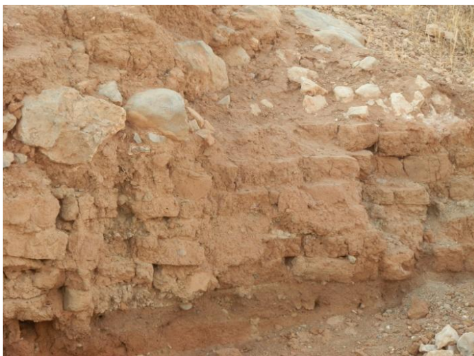
Fig.6: Strutture in mattone crudo.
