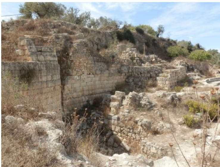
Fig. 50: Samaria, muro di sostruzione dell'acropoli, 2011.
