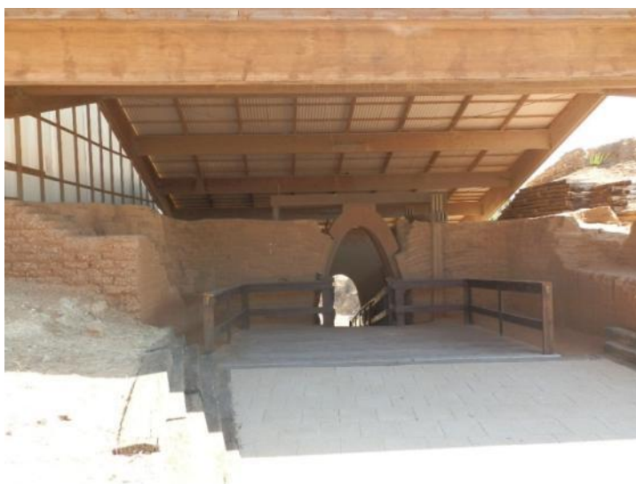
Ashkelon 2011: restauro della porta del BM
