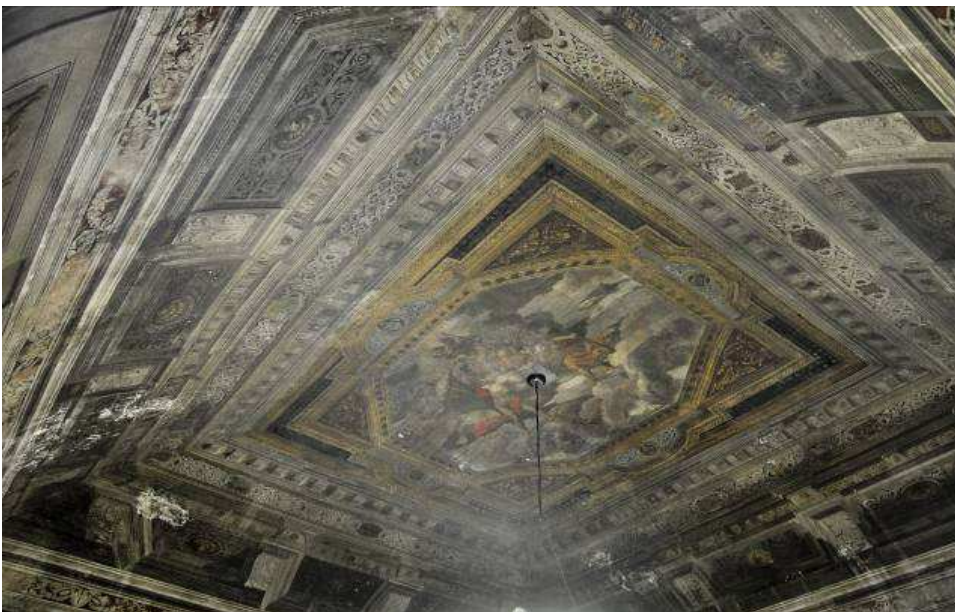
Foto 8. Particolare del soffitto della sala dell'Anagrafe. Brescia, palazzo del Broletto
