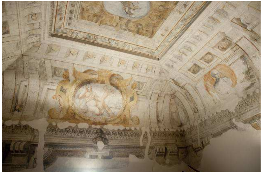
Foto 7. Particolare della volta di una sala. Brescia, palazzo Riva-Viola
