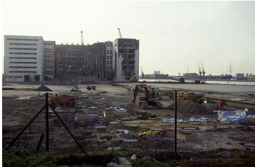
Figura 8 - Lavori ai Docklands di Londra. 110
