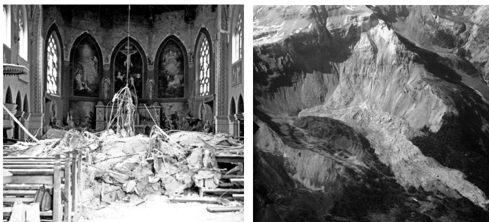
Figura 2.2 Terremoto di Sierre, 1946. Crollo del soffitto della chiesa di Chippis e frana sul Rawilhorn.
