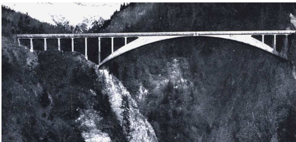
Figura 1.1 Robert Maillart, ponte Salginatobel, Schiers (GR), 1929-1930. Il ponte, con luce di 90 m e dotato di una struttura ad arco a tre cerniere, è considerato una pietra miliare dell'ingegneria civile (dal 1991 è riconosciuto ufficialmente come International Historic Civil Engineering Landmark ).
