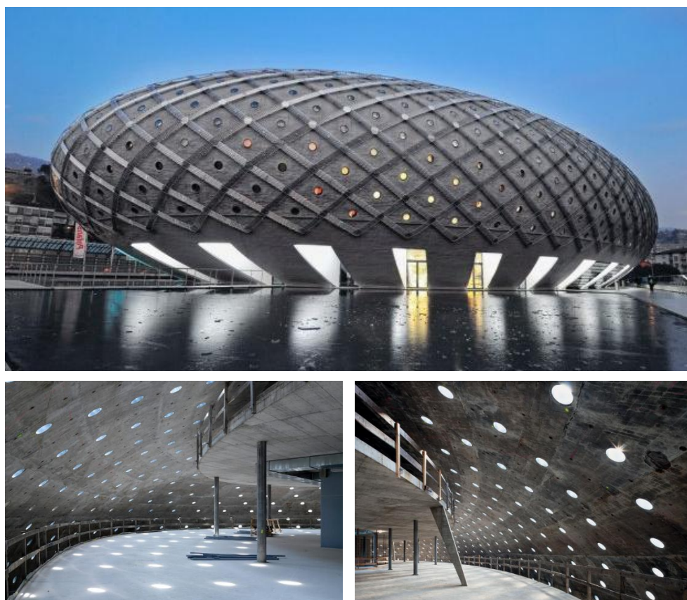
Figura 1.14 Elio Ostinelli (ing. Lurati Muttoni Partner SA), Centro Commerciale Ovale, Chiasso (TI), 2011. Il guscio esterno, spesso dai 10 ai 12 cm e realizzato in c.a.p. fibrorinforzato, avvolge i 5 piani del centro commerciale. Le solette, indipendenti dal guscio, hanno spessore limitato e sono sostenute lungo il perimetro da pilastri in c.a. centrifugato e da pilastri obliqui gettati in opera.
