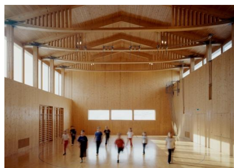
Figura 1.15 Gion A. Caminada (ing. Jürg Conzett), Sala polifunzionale, Vrin (GR), 2003. La forma insolita delle capriate lignee è un riferimento alla copertura in c.a. dei Magazzini Generali di Chiasso di Maillart, progettato seguendo il diagramma del momento flettente ( in basso a sinistra ). Il tirante non è inoltre realizzato con una tradizionale trave lamellare incollata, ma per mezzo di un assemblaggio di singole lamelle ancorate in estremità ai puntoni mediante dei ganci metallici. Una serie di puntoni verticali permette infine di deviare la forza di trazione del tirante in prossimità dell'appoggio, riducendo così la compressione e la lunghezza di libera inflessione del puntone.
