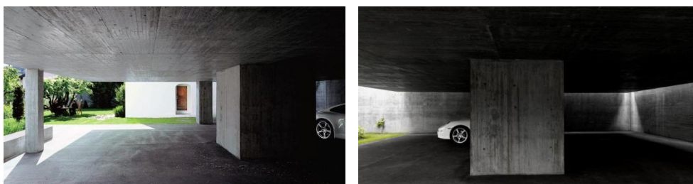
Figura 3.14 Struttura in c.a. del PT: nucleo, pilastri di bordo e soletta in c.a.p. staccata dalla parete.
