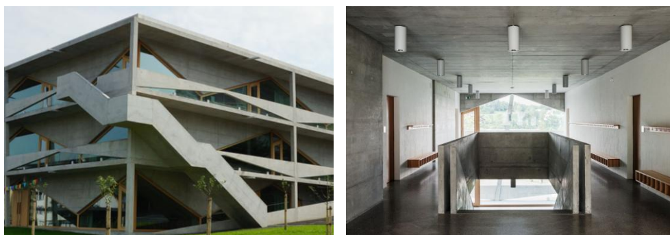
Figura 3.12 A sinistra: scala esterna lato nord e parapetti dei ballatoi. A destra: scala interna.
