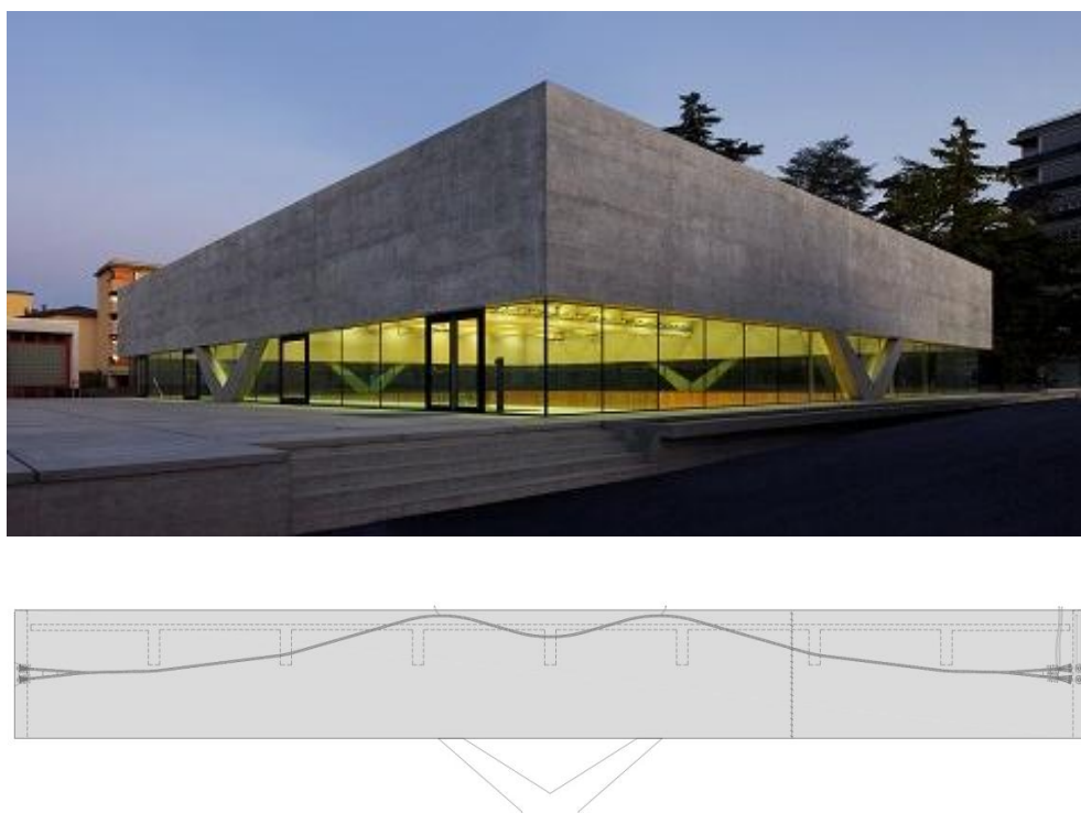
Figura 1.12 Baserga Mozzetti (Ingegneri Pedrazzini Guidotti SAGL), Palestra doppia, Chiasso (TI), 2010. L'intera copertura della palestra appoggia sui soli 4 elementi a forcella disposti lungo il perimetro. Dettaglio del tracciato dei cavi di precompressione delle travi parete perimetrali.
