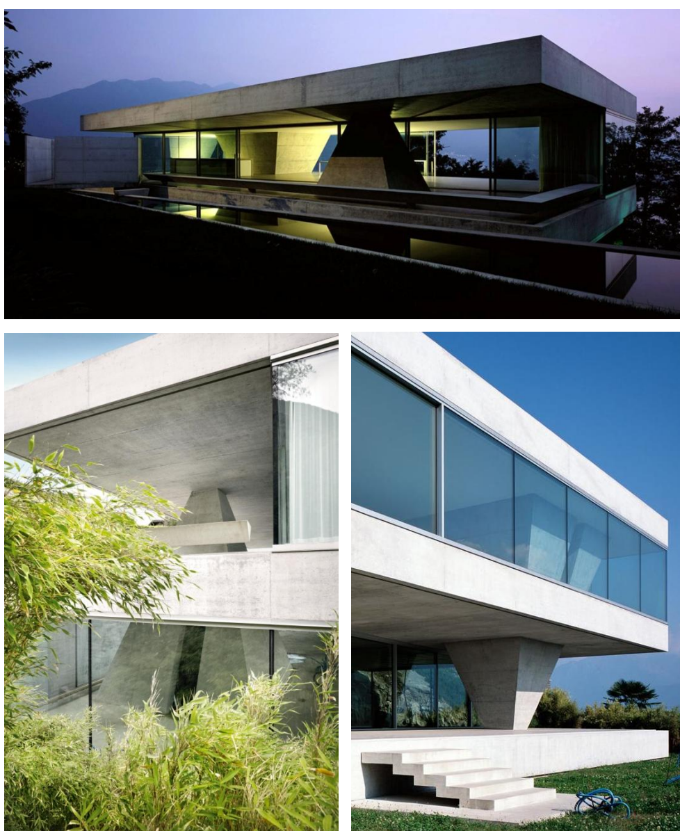
Figura 3.23 Le piramidi e la simmetria centrale della struttura. In alto : il chiaroscuro evidenzia il rapporto tra le due piramidi rovesciate e contrapposte. In basso a sinistra : la piramide dritta nell'angolo nord. In basso a destra : la piramide rovescia nell'angolo sud. Le basi delle piramidi sono interne agli appartamenti ed ospitano i bagni; le metà relative ai vertici risultano esterne e piene.
