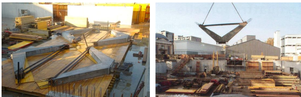
Figura 3.42 Forcelle miste in acciaio-calcestruzzo di appoggio delle facciate. In alto : struttura metallica e gabbia di armatura. All'interno dei tubolari (ROR 273.25/S355) sono alloggiati i pluviali ed i cavi elettrici della copertura. In basso : il getto di completamento delle quattro forcelle è stato realizzato a terra in cantiere. Il posizionamento delle forcelle è avvenuto mediante autogrù sfruttando delle barre manicottate uscenti dalle pareti del basamento, alle quali è stata avvvitata la piastra di base delle forcelle. Successivamente si è potuto completare il getto della parete.
