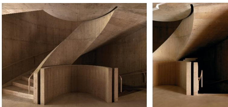
Figura 3.2 Scala interna semicircolare: cura del dettaglio strutturale.
