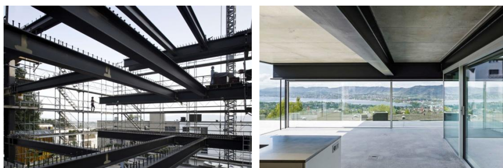
Figura 3.26 Struttura della casa. In alto : assonometria della struttura metallica (disegno Dr. Schwartz Consulting). In basso a sinistra : veduta dell'angolo a sud sgombro da elementi portati verticali durante la fase di cantiere. In basso a destra : la vista sul lago di Zurigo e la struttura finita dopo la realizzazione della soletta in c.a.p. collaborante.
