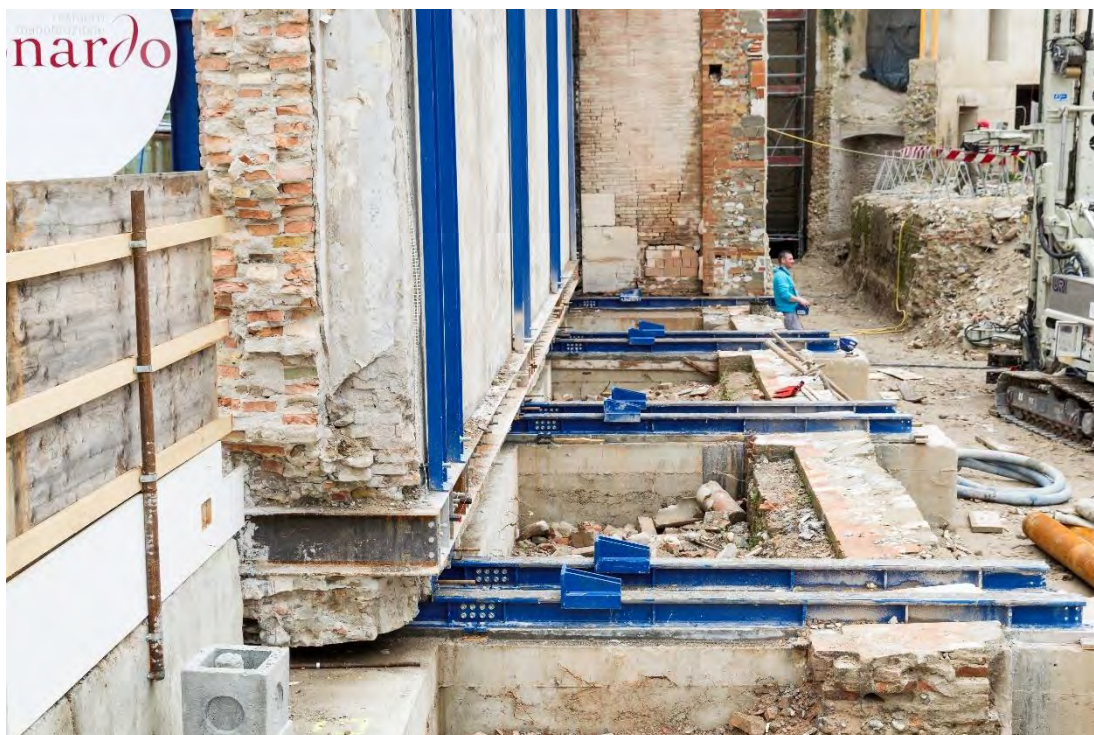
Figura 62: Particolare dell'impianto della struttura meccanica per l'intervento di traslazione. (A.P.M.)
