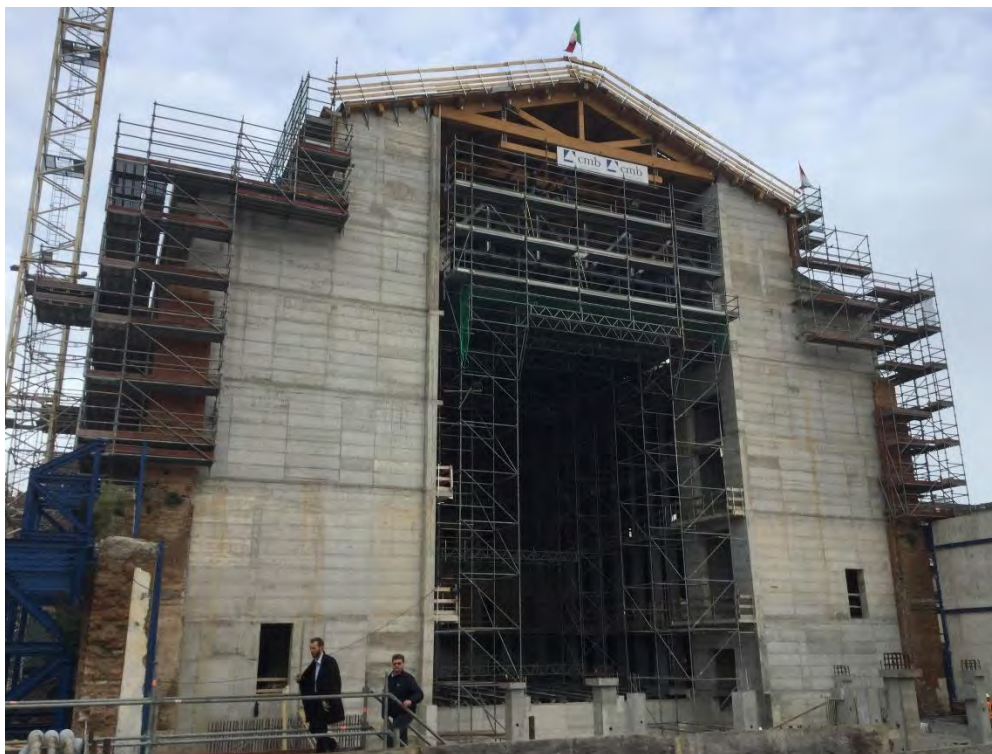
Figura 67: Foto dello stato aggiornato del cantiere con la realizzazione della copertura sopra la sala. (Foto L. Petriccione)
