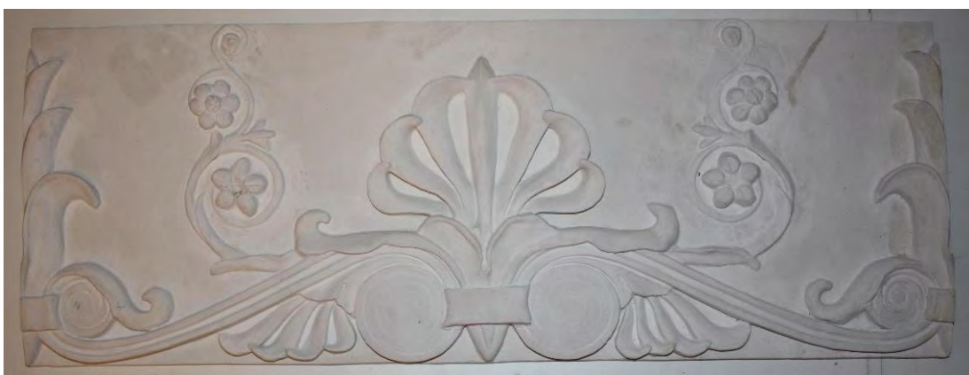
Figura 82: Particolare del mock-up del fregio realizzato in gesso dallo Studio Forme. (Foto L.Petriccione)
