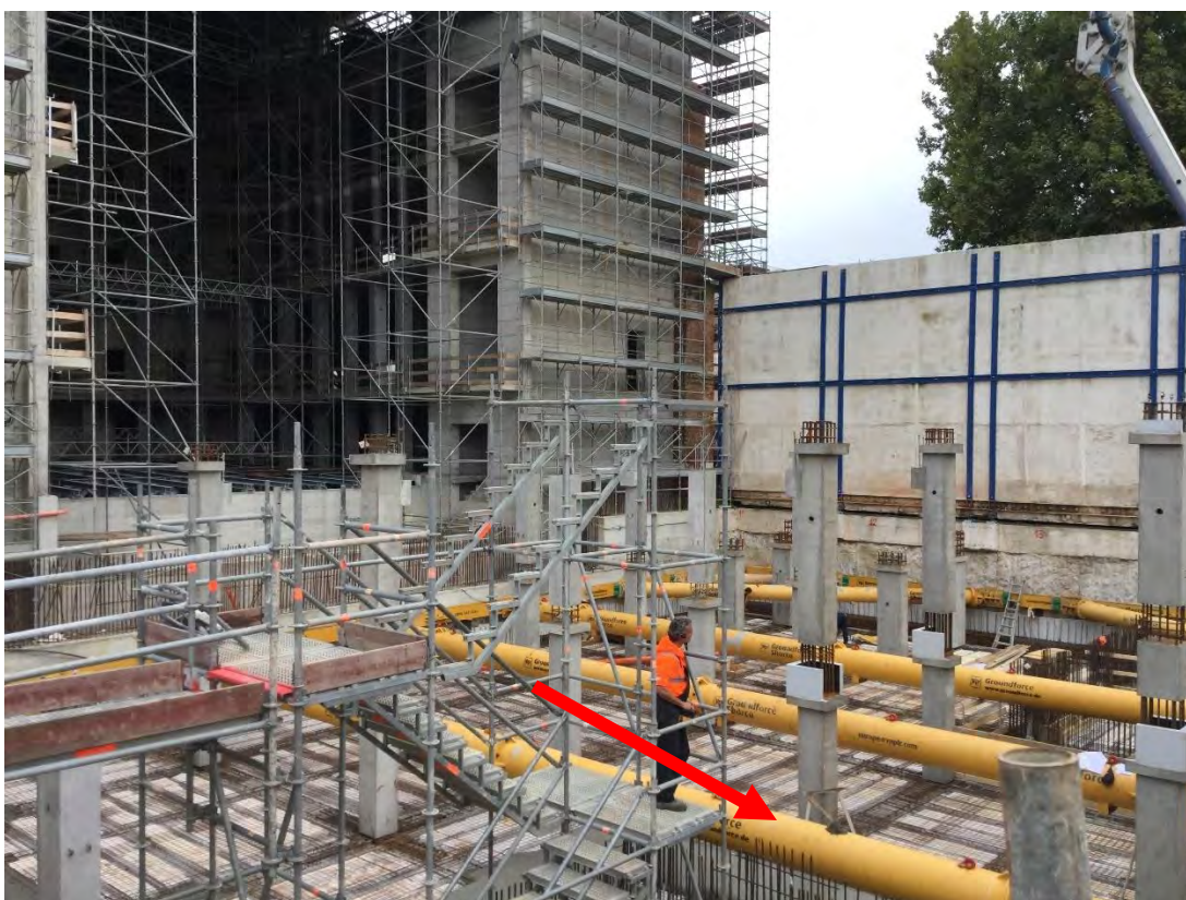
Figura 65: Foto di cantiere durante le fasi di realizzazione dell'area sotto il palco con l'inserimento di sistema di puntoni idraulici in acciaio in evidenza. (Foto L. Petriccione)
