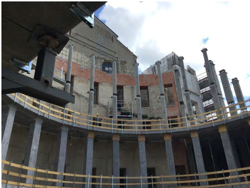
Figura 64: Foto del cantiere della ricostruzione, particolare della struttura in calcestruzzo della zona dei palchetti. (Foto L. Petriccione)
