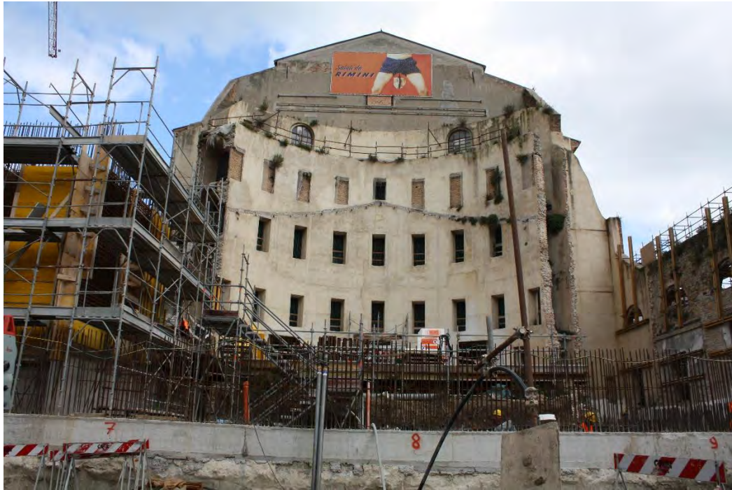
Figura 63: Foto delle fasi iniziali di avvio del cantiere di ricostruzione. (Foto L. Petriccione)
