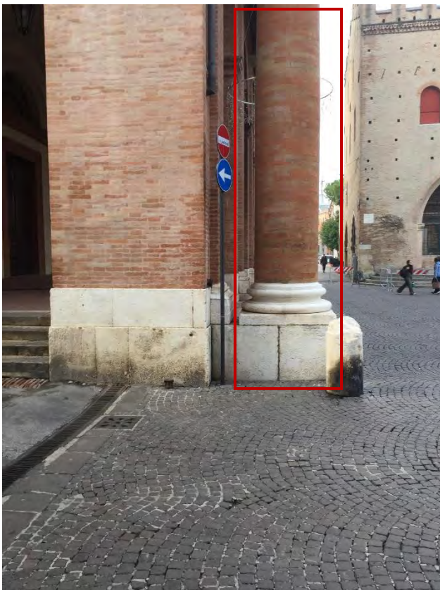
Figura 18: Particolare del basamento della colonna della facciata principale del teatro Amintore Galli di Rimini da cui si evince l'addossamento del colonnato del prospetto polettiano alla esistente struttura ad archi dei "Forni". (Foto L. Petriccione)
