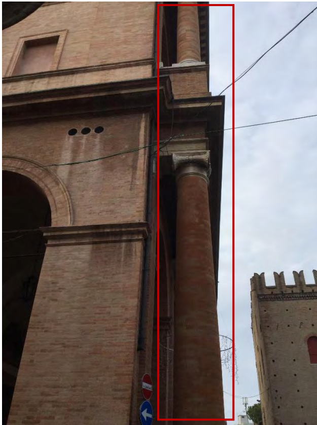
Figura 17: Particolare dell'architrave e del colonnato della facciata principale del teatro Amintore Galli di Rimini, da cui si evince l'addossamento del colonnato del prospetto polettiano alla esistente struttura ad archi dei "Forni". (Foto L. Petriccione)
