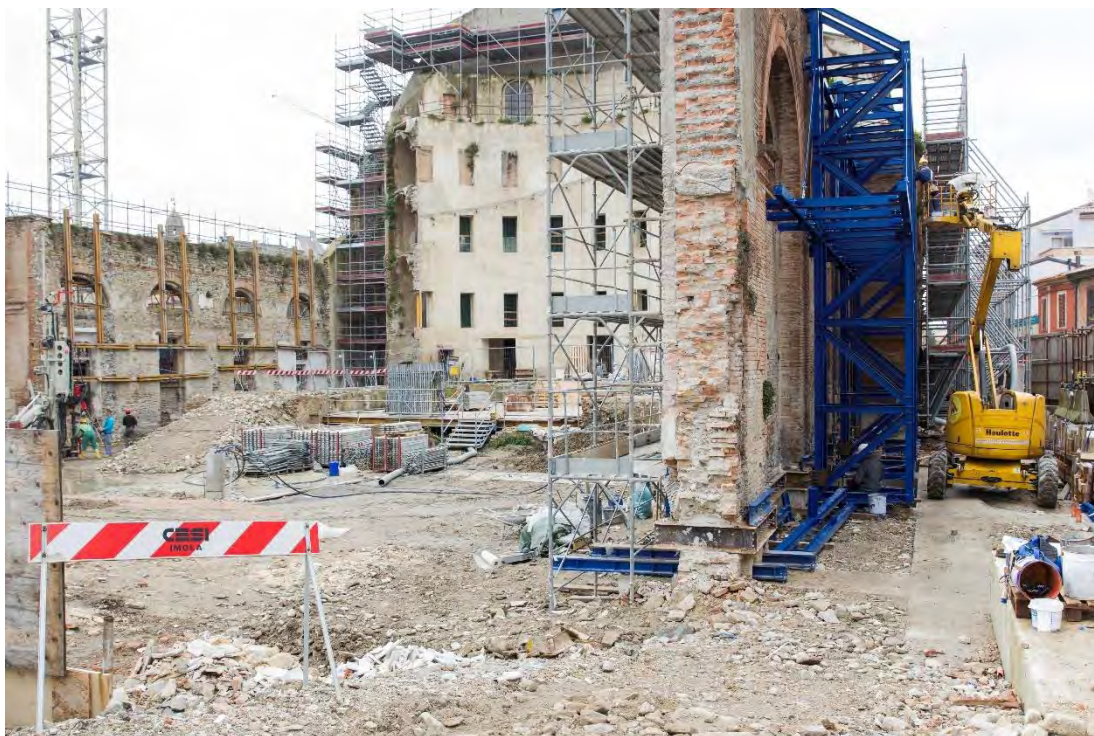
Figura 61: Foto del cantiere di ricostruzione durante le fasi della traslazione del muro originario del teatro per la costruzione delle fondazioni. (A.C.R.)
