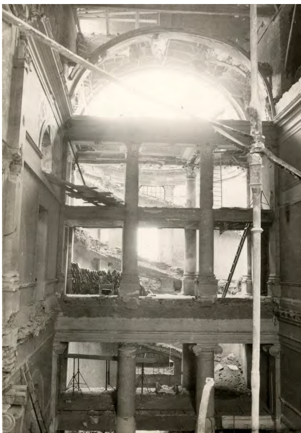
Figura 47: Foto dei lavori di restauro eseguiti all'interno del teatro nel periodo post bellico. (Foto B.G.R.)
