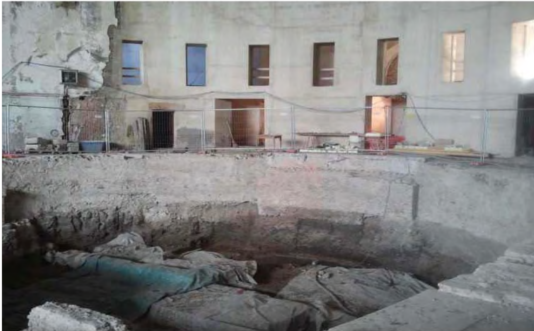
Figura 55: Immagine delle fondazioni della cavea del Poletti rinvenute durante gli scavi archeologici. (A.C.R.)
