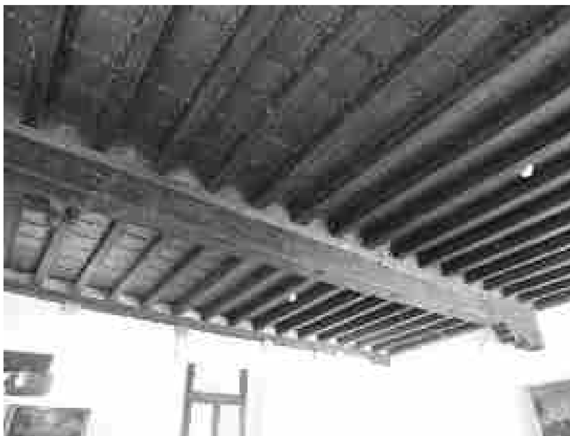
Soffitto di palazzo de Claricini Dornpacher.
