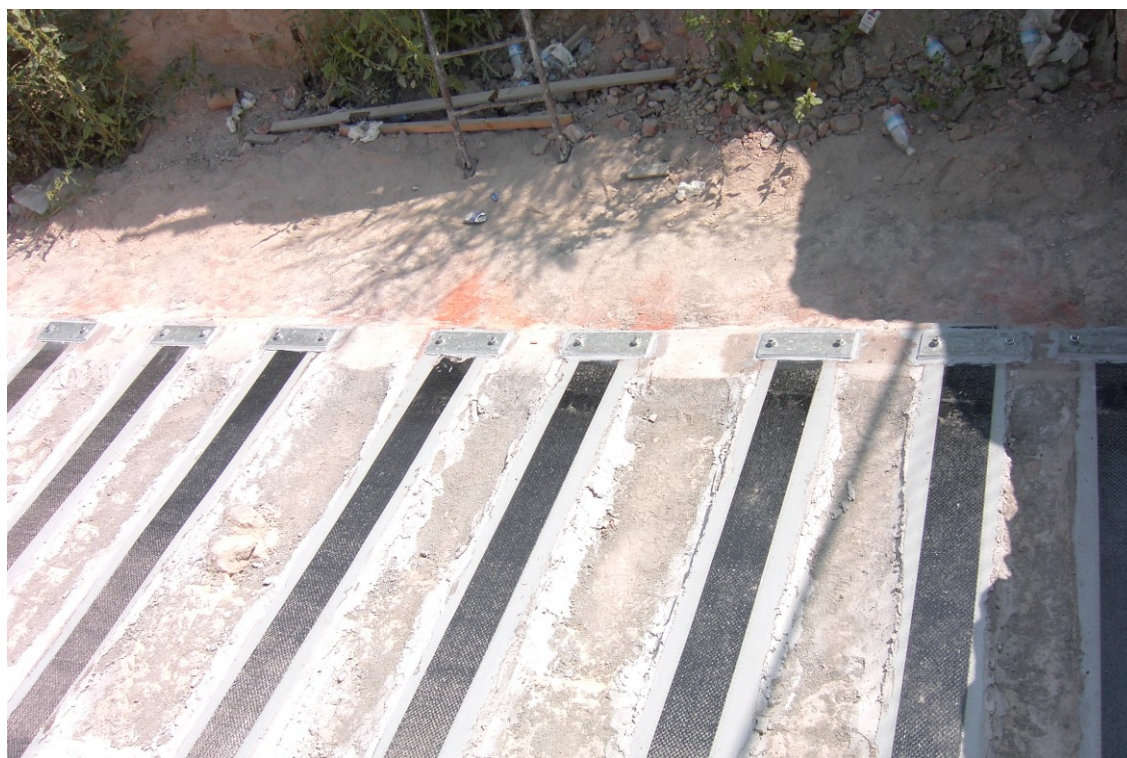
Fig. 5.54. Fissaggio meccanico dei rinforzi nella parte terminale
