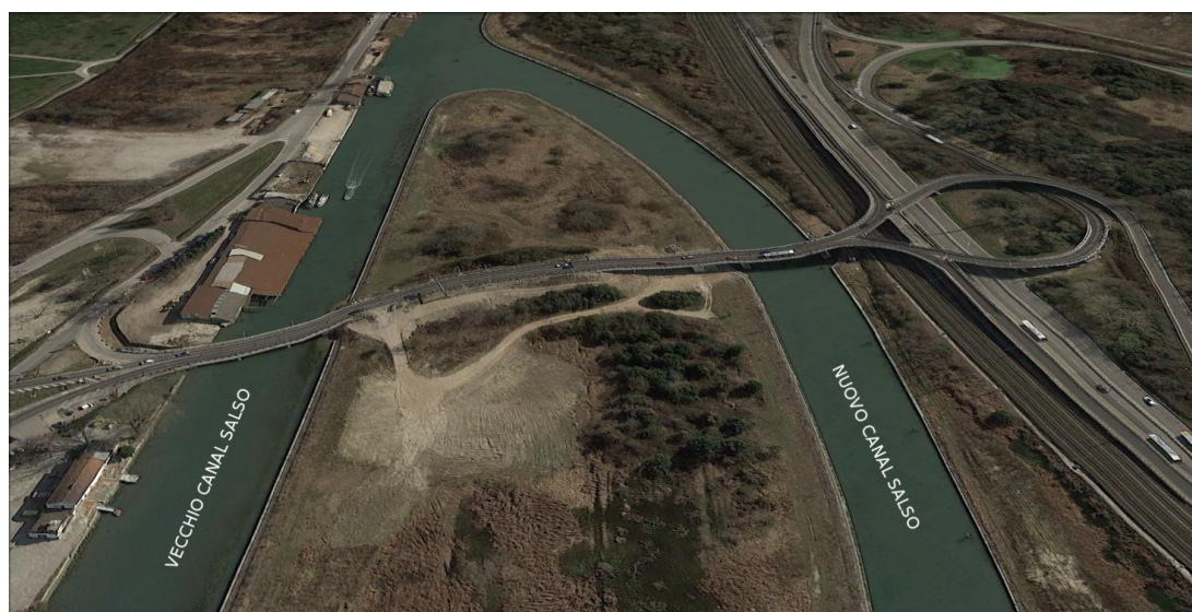
Fig. 3.1. Vista generale del viadotto "San Giuliano"
