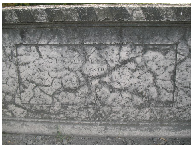
Fig. 4.4. Specchiatura in pietra sul parapetto sud del ponte
