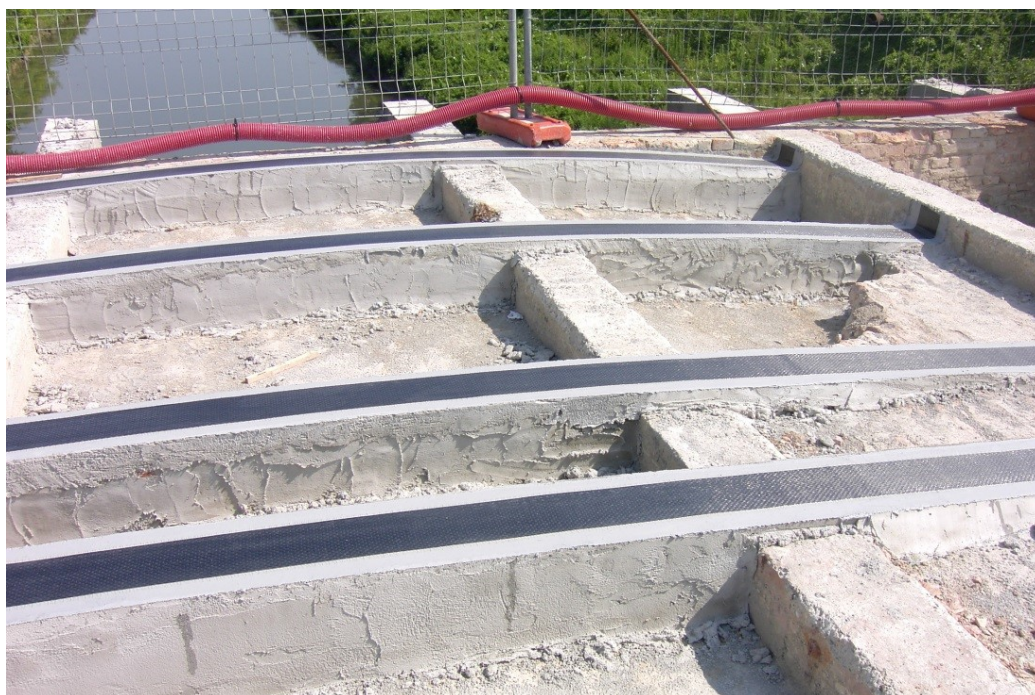
Fig. 5.52. Completamento supporti e incollaggio FRP
