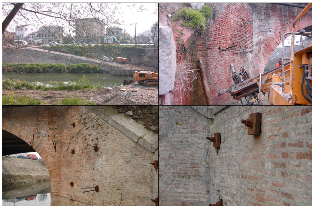
Fig. 5.49. Realizzazione tirantaggio muri d'ala
