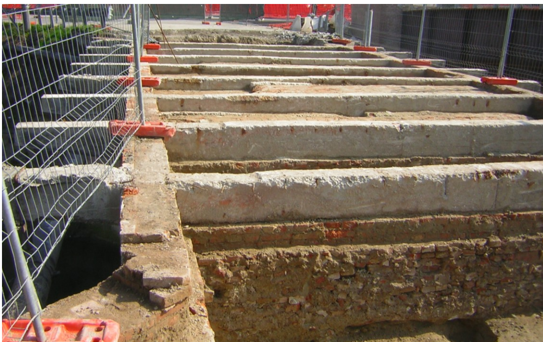
Fig. 5.8. Foto dell’impalcato del ponte
