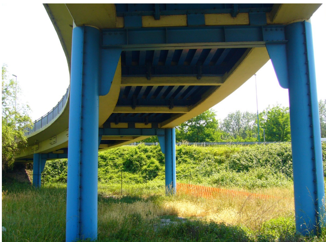
Fig. 3.5. Interventi di rinforzo delle rampe
