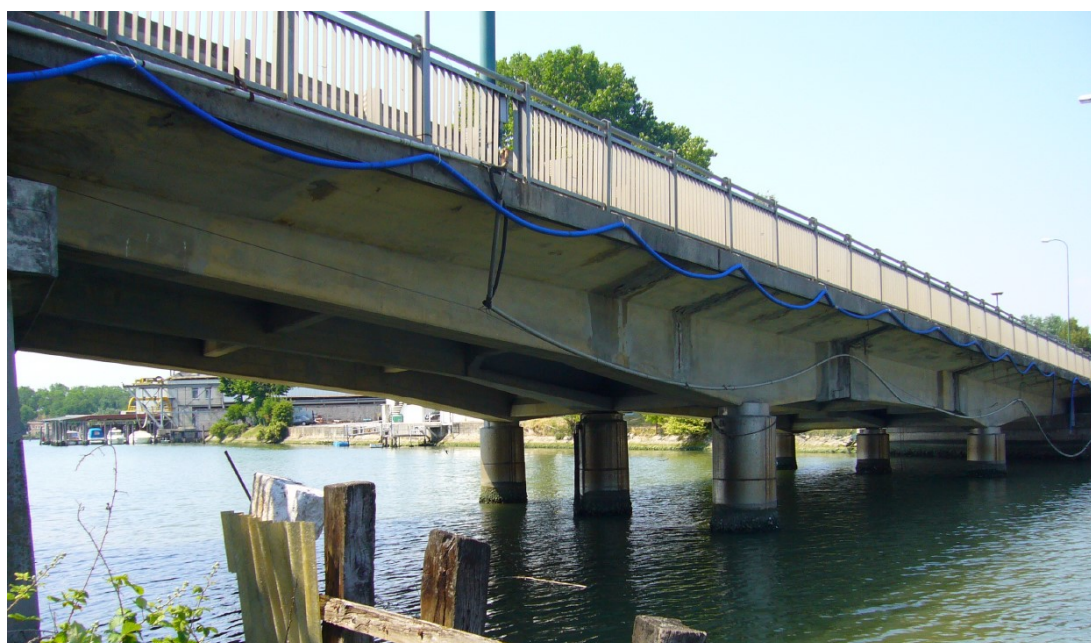
Fig. 3.2. Vista del ponte sul "vecchio canal salso"
