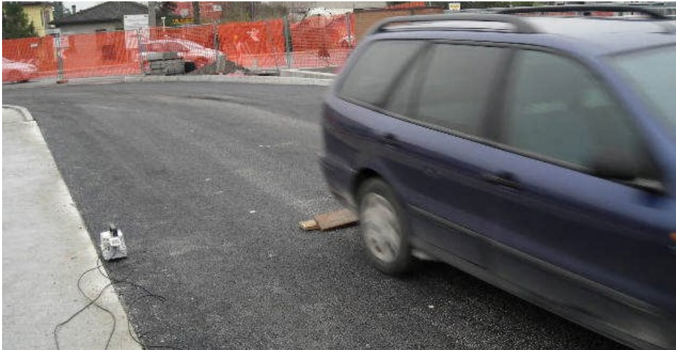
Fig. 5.57. Esecuzione della prova dinamica post-retrofitting
