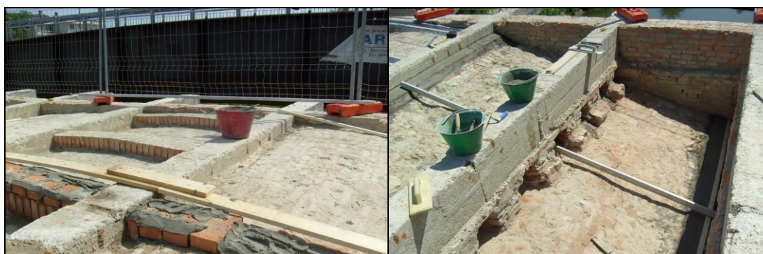
Fig. 5.51. Realizzazione delle tasche nei traversi e dei supporti in muratura
