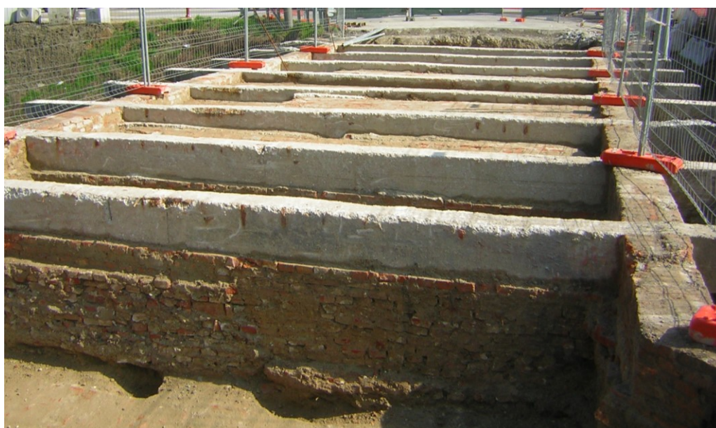
Fig. 5.50. Vista dell'estradosso dell'arco
