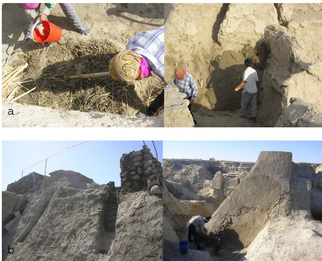
Fig. 4. (a) Preparazione dell'impasto impiegato per la risarcitura delle fessurazioni e sua posa in opera; (b) manutenzione della sommità del bastione mediante l'impiego di adobe o pachsà e stesura finale dell' intonaco di sacrificio . (Désirée De Antoni)
