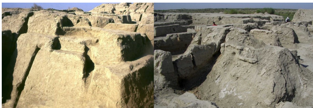
Fig. 2. Processo di erosione subito dal bastione sud-est dal 1999 al 2008. (Franca Filipponi, Désirée De Antoni)
