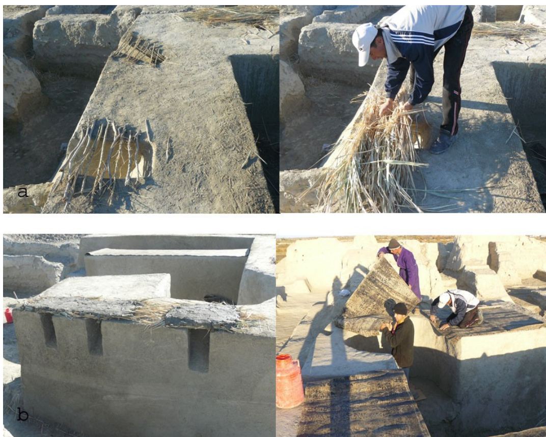
Fig. 6. Manutenzione preventiva: gli interventi di protezione superficiale provvisoria. Sequenza di posa in opera degli strati di protezione sul margine superiore del bastione: (a) rami e paglia; (b) malta di terra e carta catramata. (Silvia Pozzi)
