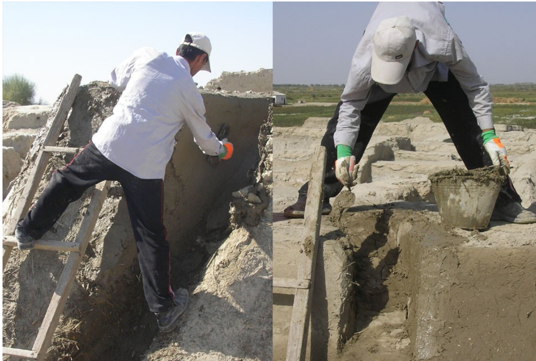
Fig. 5. Stesura dell' intonaco di sacrificio a protezione della zona delle feritoie. (Désirée De Antoni)
