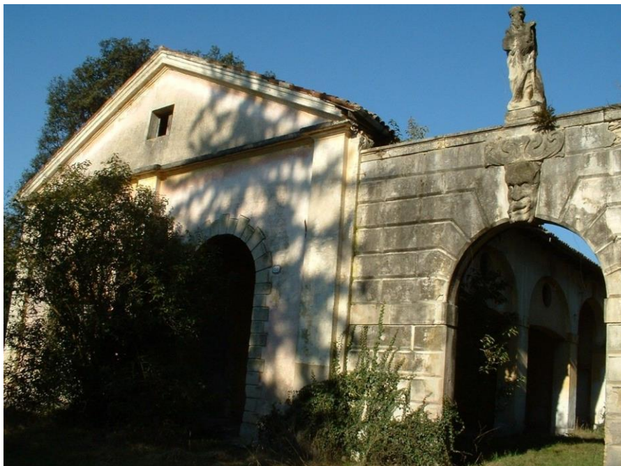
Fig. 4.8 - Nello scatto si vede la barchessa ovest con parte dell'elemento che la collega al corpo principale della villa; tali elementi sono in bugnato gentile e presentano un'apertura ad arco con in chiave un mascherone "mostruoso", il tutto è sormontato da una statua antropomorfa, simile a quelle che un tempo erano presenti sulle barchesse.
