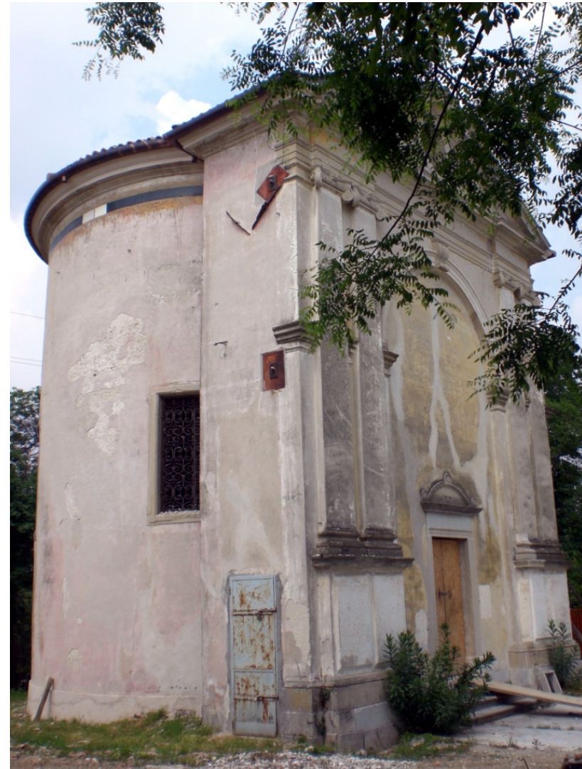
Fig. 5.42 Prospetto laterale della cappella, ripreso dalla villa.
