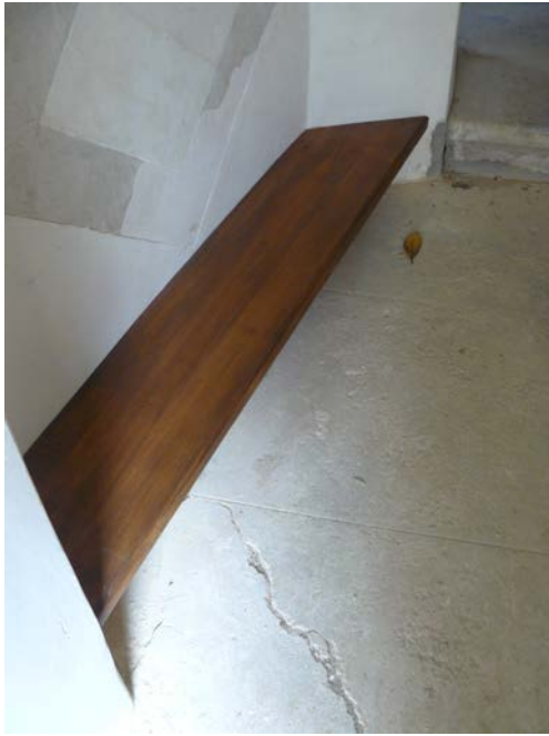
Fig. 5.73 – Dettaglio delle sedute in piccole dimensioni ricavate nelle nicchie
