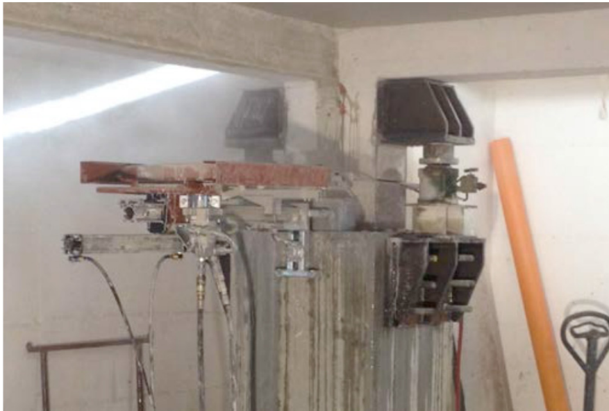
Fig. 6. 31 - Foto di cantiere riferibile al taglio dell'elemento in calcestruzzo in eccesso
