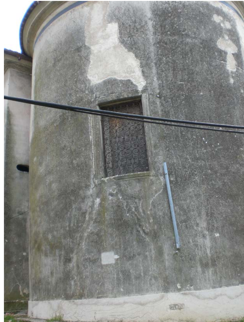
Fig. 5.45 Rimozione meccanica degli intonaci e degli rappezzi cementizi accertati come non originali.
