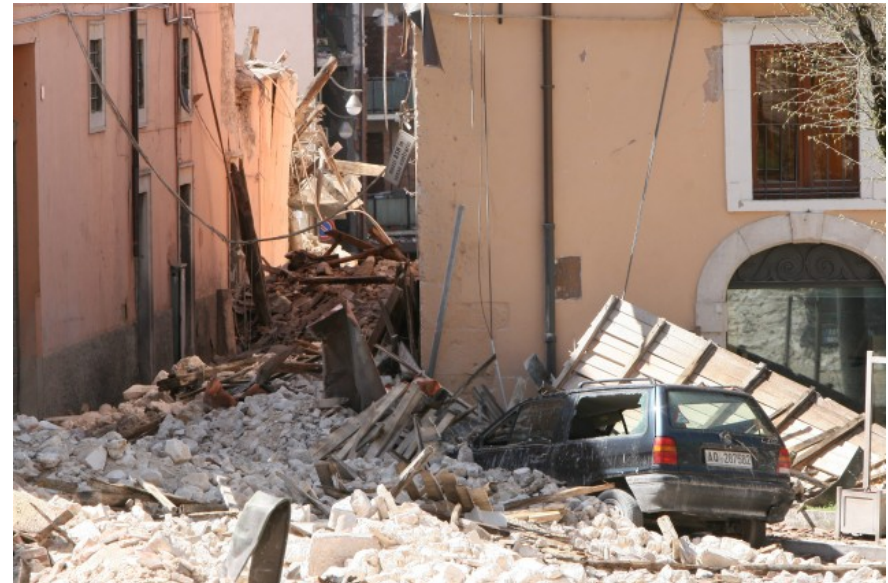
Fig. 6. 26 – Condizioni degli edifici prossimi al condominio Leonardo, Aquila 2009.
