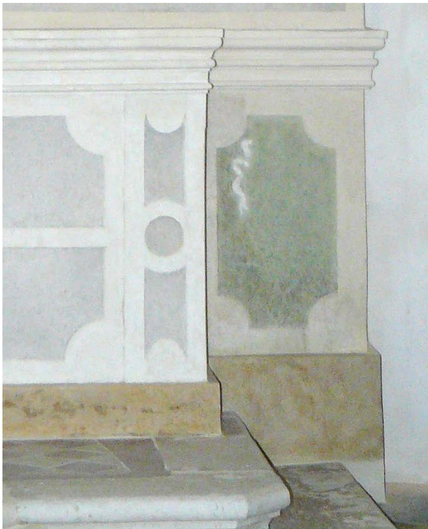
Fig. 5.58 Cappella gentilizia. Particolare delle specchiature in marmorino dopo il restauro
