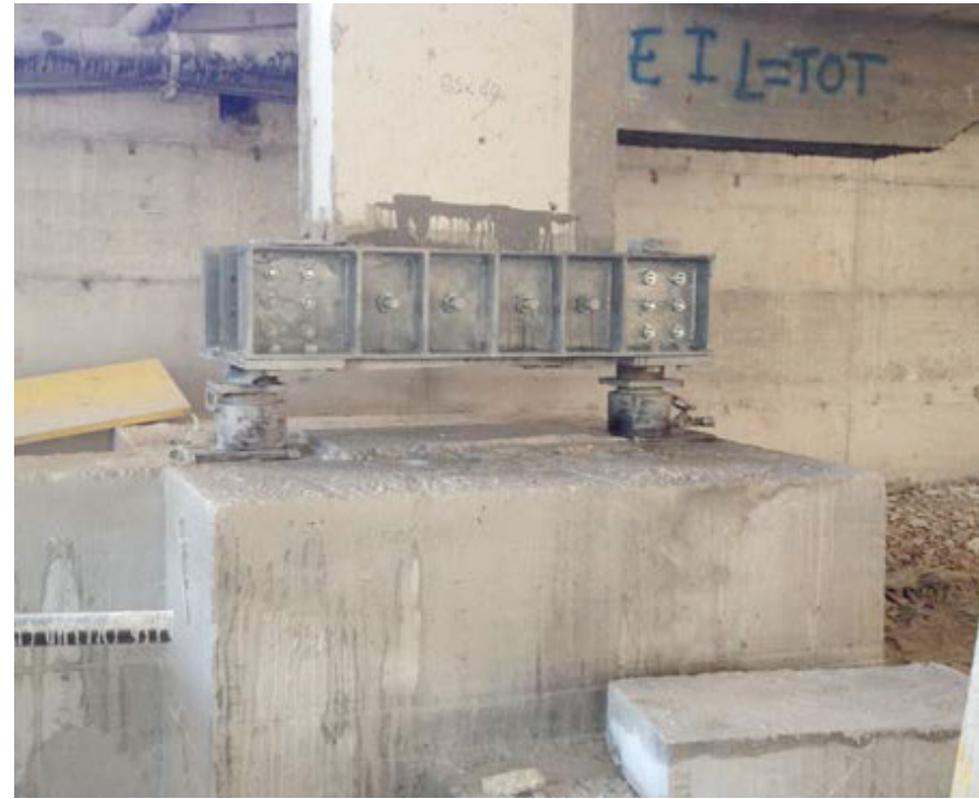
Fig. 6. 20 - Foto di cantiere riferibile alla estrazione del cubo in eccesso
