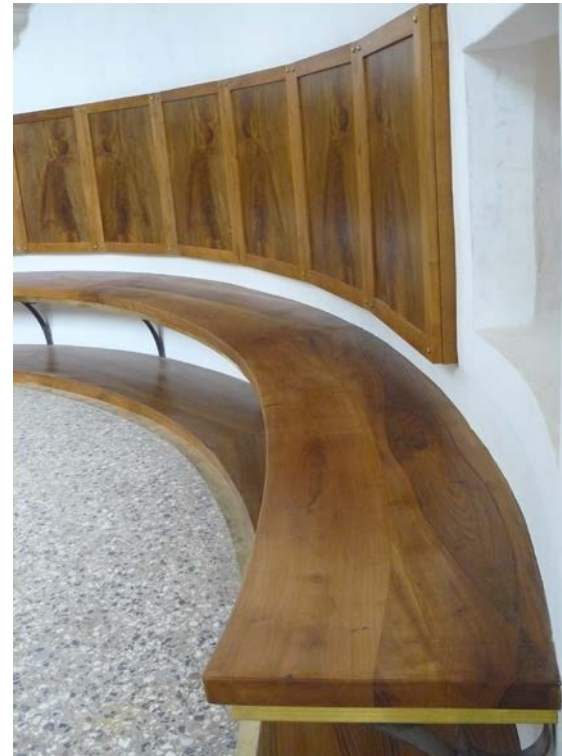
Fig. 5.78 – Quadrettoni dello schienale del coro realizzato il legno di larice rosa
