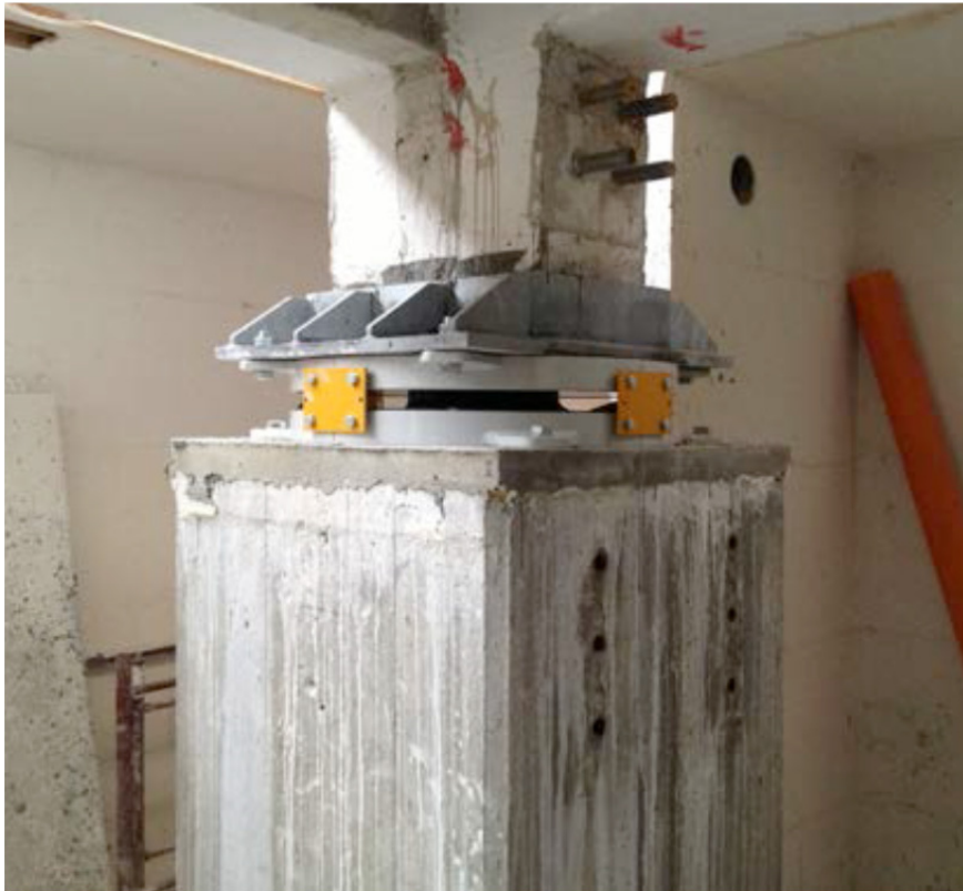
Fig. 6. 35 – Foto di cantiere riferibile alla rimozione dei martinetti idraulici
