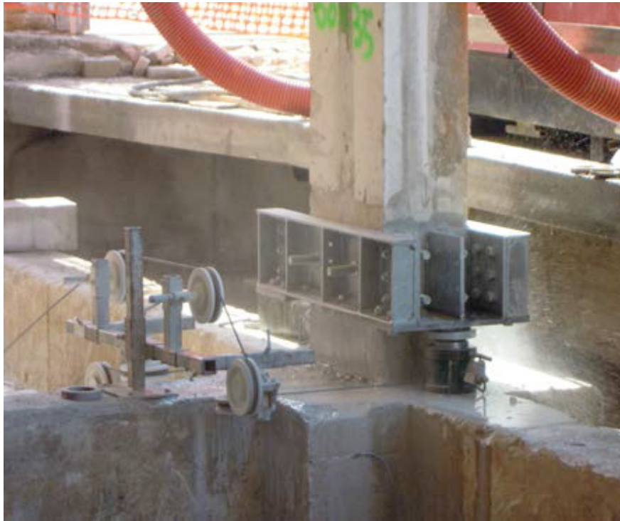
Fig. 6. 19 - Foto di cantiere riferibile al taglio del pilastro alla base
