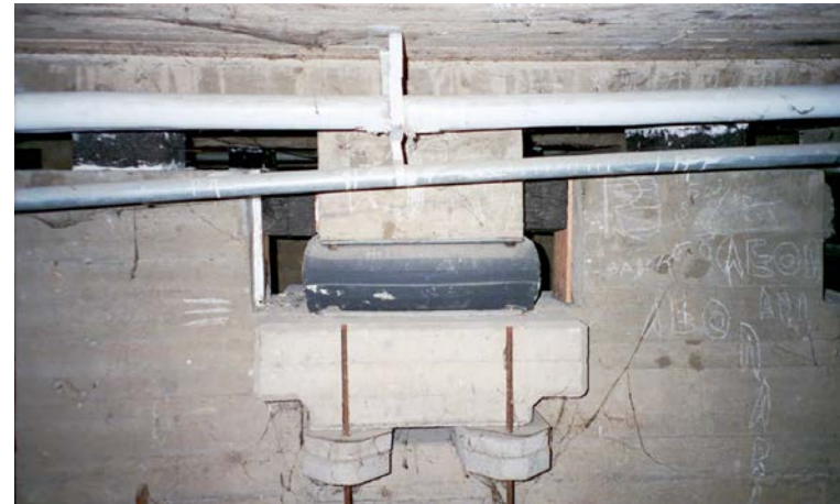
Fig. 2.27 – Dettaglio del primo isolatore, scuola elementare Enrico Pestalozzi, 1964, Skopje, Macedonia, archivio prof. James M. Kelly.
