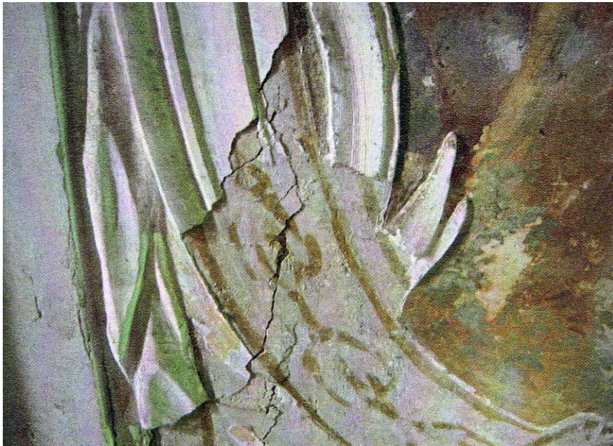
Fig. 5.38 Lacuna. A causa del degrado si è persa parte di questa cornice presente nel corridoio-galleria del piano nobile.
