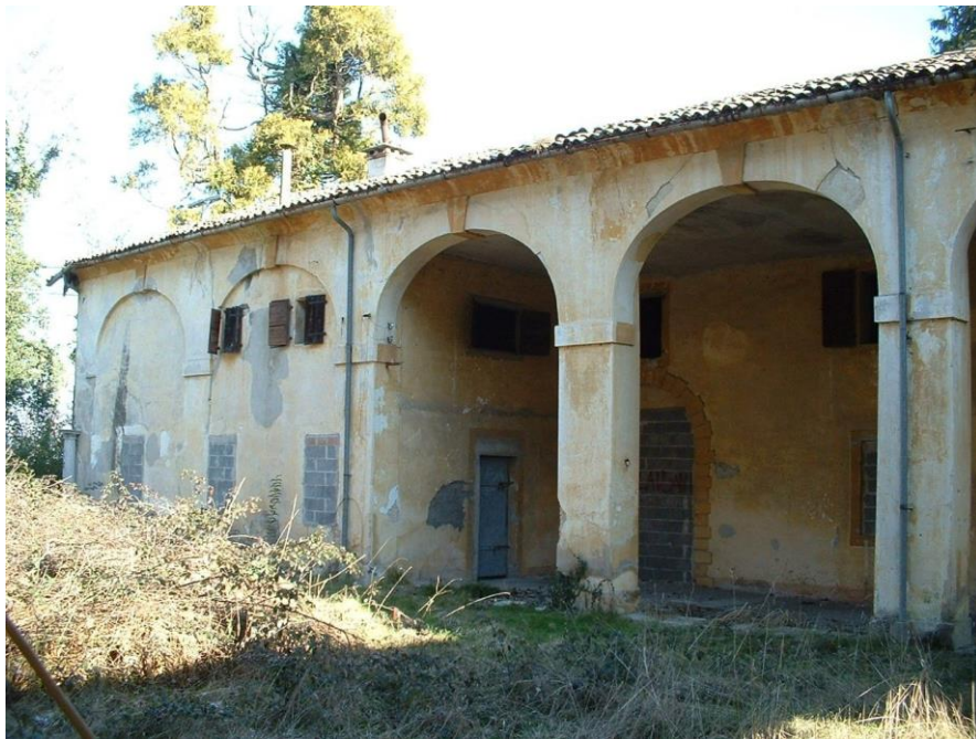
Fig. 4.9 - Barchessa est, fronte affacciante sulla corte interna.
