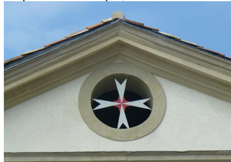
Fig. 5.88 – Croce di Malta con bracci bianchi e centro rosso posizionata nell'apertura circolare del timpano, dettaglio apertura.
