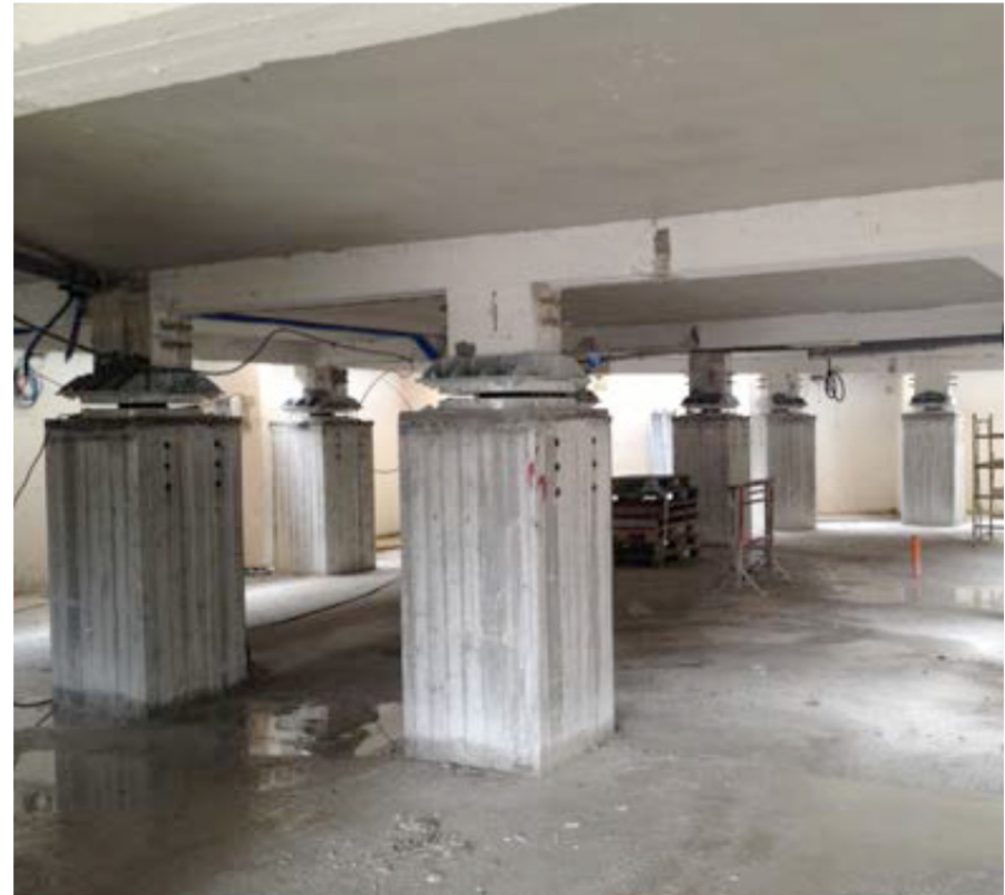
Fig. 6. 36 - Foto di cantiere riferibile alla messa in carico degli isolatori installati
