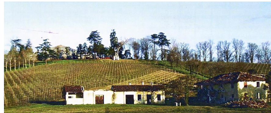
Fig. 4.7 - Veduta del colle di Monticella sulla cui sommità si scorge la villa "avvolta" dalle impalcature.
