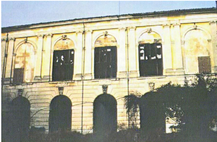
Fig. 4.13 - Prospetto principale della villa, si nota il bugnato al piano terra, le grandi finestre al piano nobile, di cui le tre centrali danno luce alla sala da ballo.
