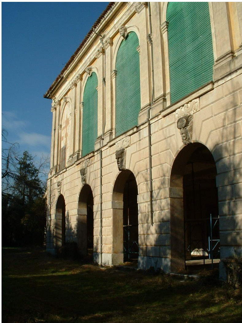
Fig. 4.11 - Fronte principale in cui si può apprezzare la lavorazione a bugnato gentile del loggiato.
