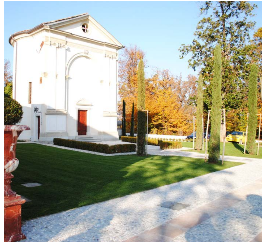
Fig. 5.89 – Vista laterale della cappella gentilizia restaurata con il sagrato in bosso e collegamento pedonale in pietra, realizzato in asse con l'ingresso, ai lati del quale sono stati piantati quattro piccoli cipressi.
