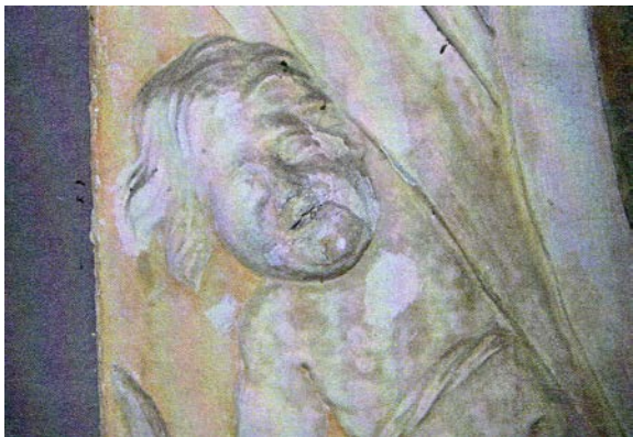
Fig. 5.35 Polverizzazione e scagliatura. Il fenomeno, dovuto all'umidità interessa in maniera generalizzata tutte le superfici a stucco, che ha portato a numerose assenze di parti ammalorate.
