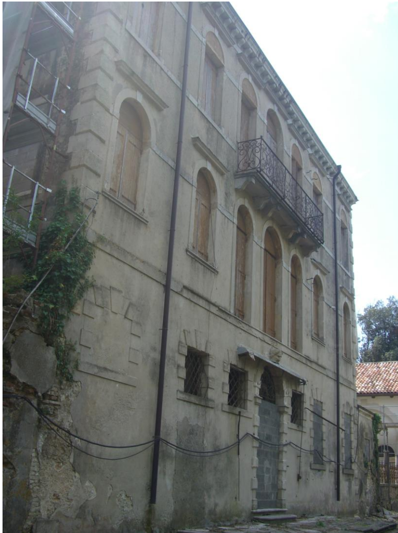
Fig. 4.14 - Fronte posteriore della villa. Affaccia a nord verso Calpena; si può notare la sobrietà dell'impaginato rispetto al fronte principale.
