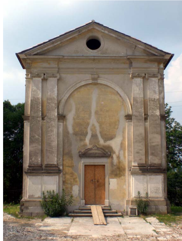
Fig. 5.41 Fronte principale dell'oratorio annesso alla villa. Prima degli interventi di restauro.
