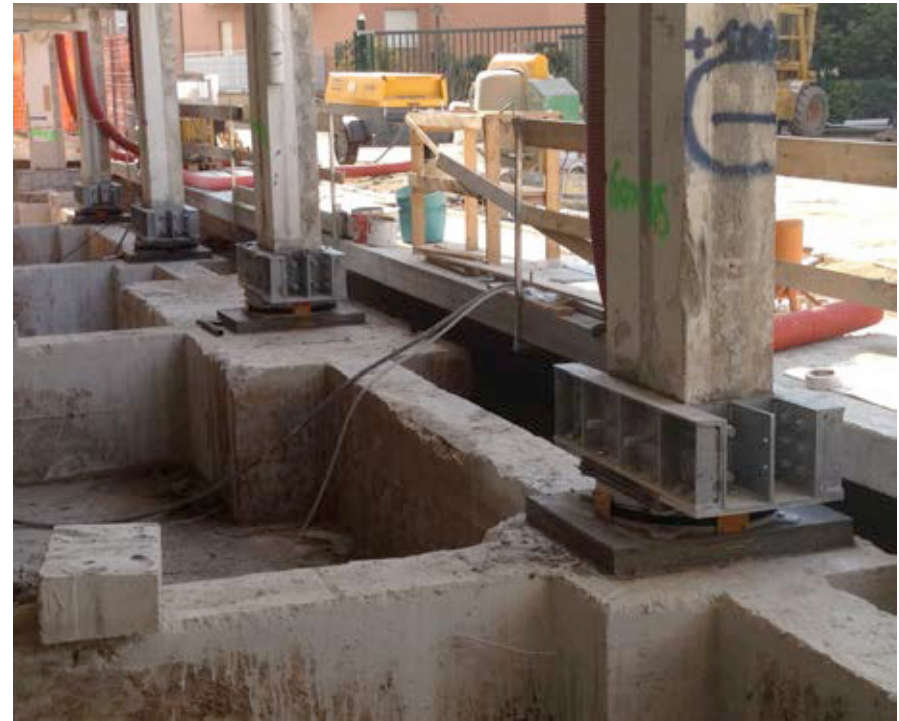
Fig. 6. 23 - Foto di cantiere riferibile all'inserimento dell'isolatore e la rimozione di martinetti idraulici
