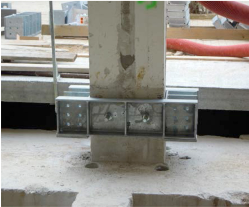
Fig. 6. 16 - Foto di cantiere riferibile alla posa della carpenteria metallica
