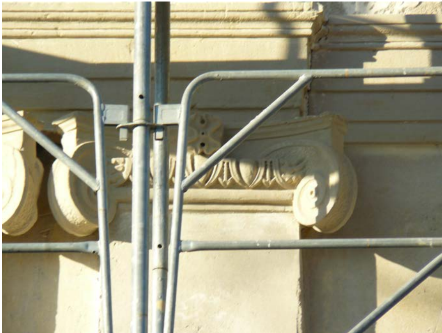
Fig. 5.48 Capitello della cappella, consolidamento con soluzioni minerali ed iniezioni a base di calce con basso tenore di sali solubili.
