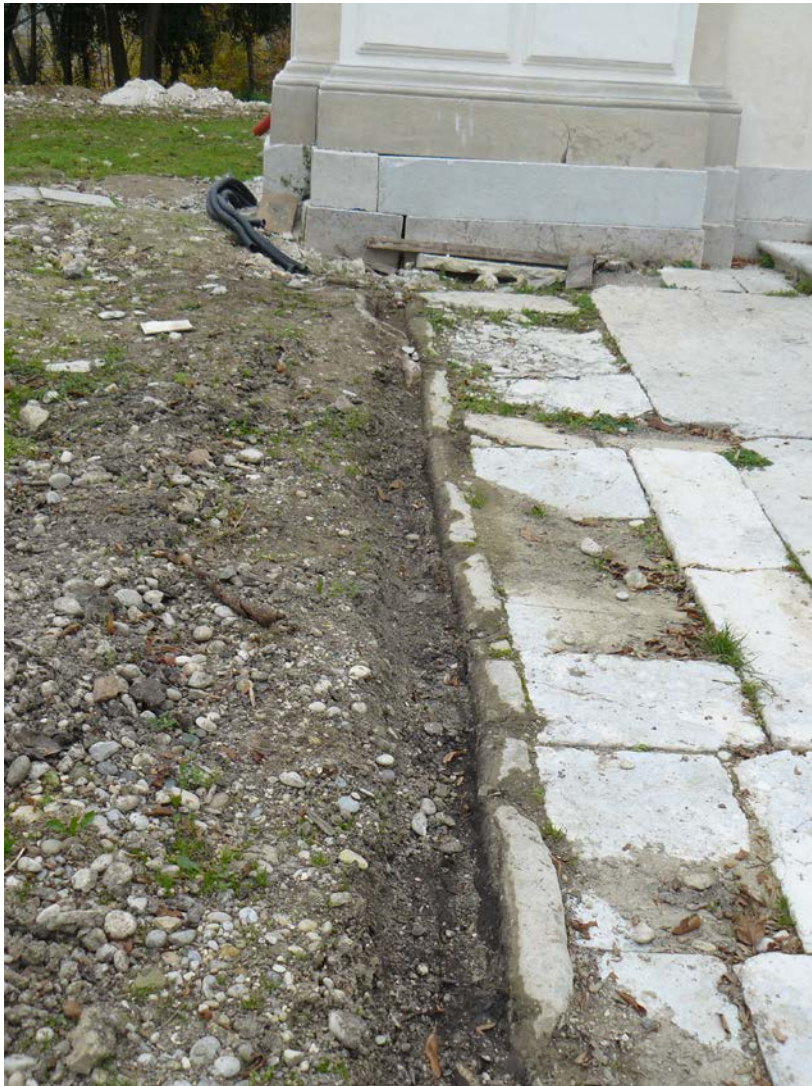
Fig. 5.61 – Ritrovamento dell'originario sedime di fabbrica a seguito dell'accurato scavo archeologico.
