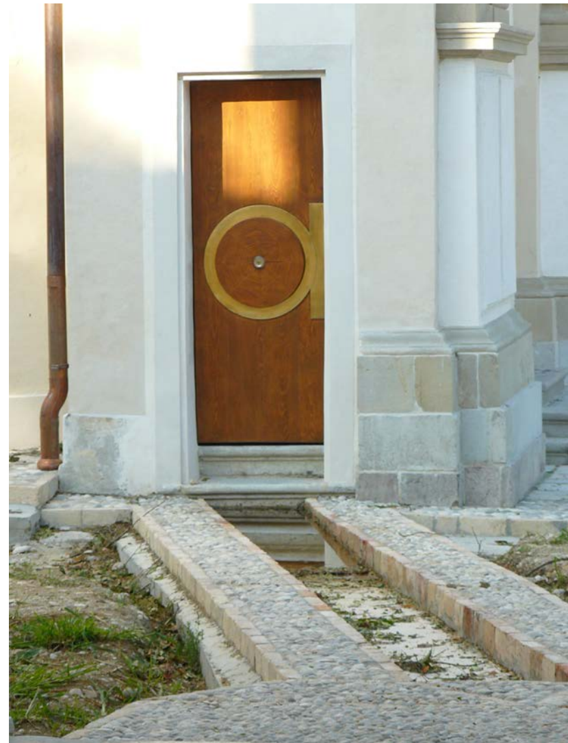
Fig. 5.69 -Vista della pavimentazione di collegamento, tra la villa e la cappella, in fase di realizzazione
