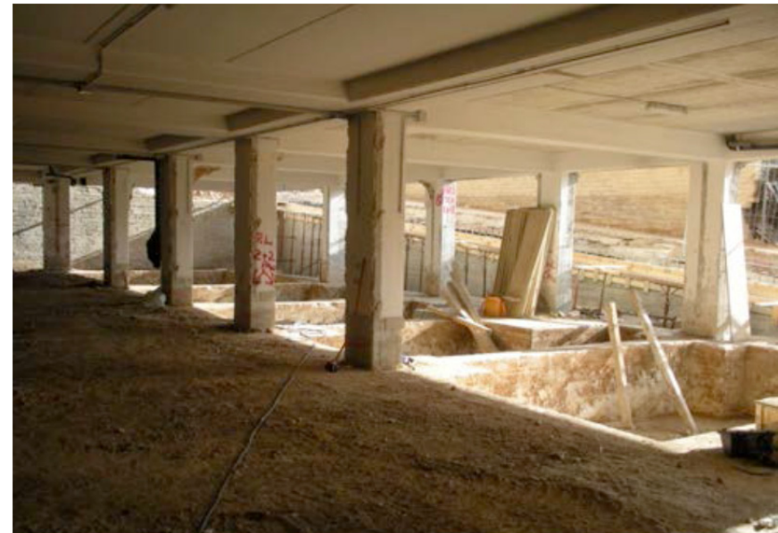
Fig. 6. 12 – Foto di cantiere riferibile alla rimozione di elementi secondari
