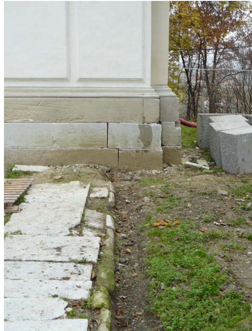
Fig. 5.62 – Ritrovamento dell'originario sedime di fabbrica a seguito dell'accurato scavo archeologico.
