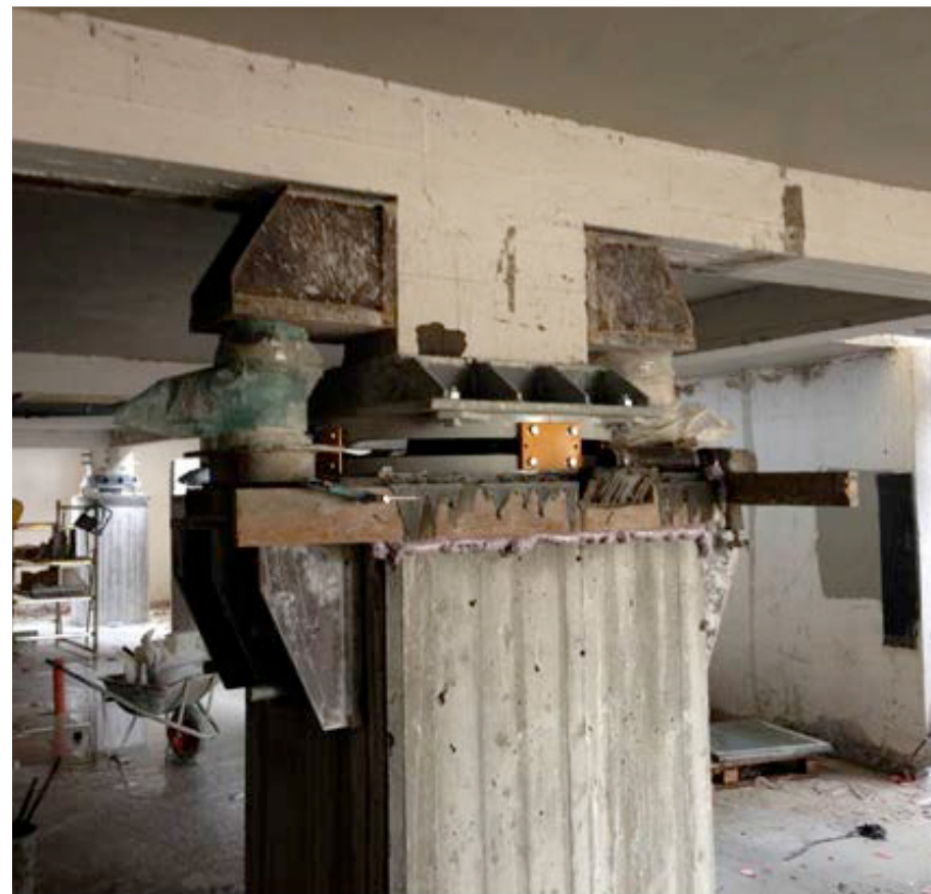
Fig. 6. 34 - Foto di cantiere riferibile alla posa dell'isolatore sopra e sotto il collare metallico
