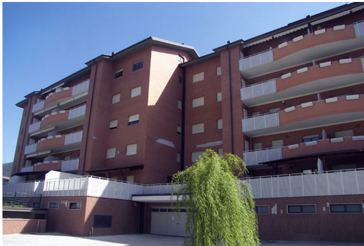
Fig. 6.9 – Condominio Domus Prima , sito all'Aquila
