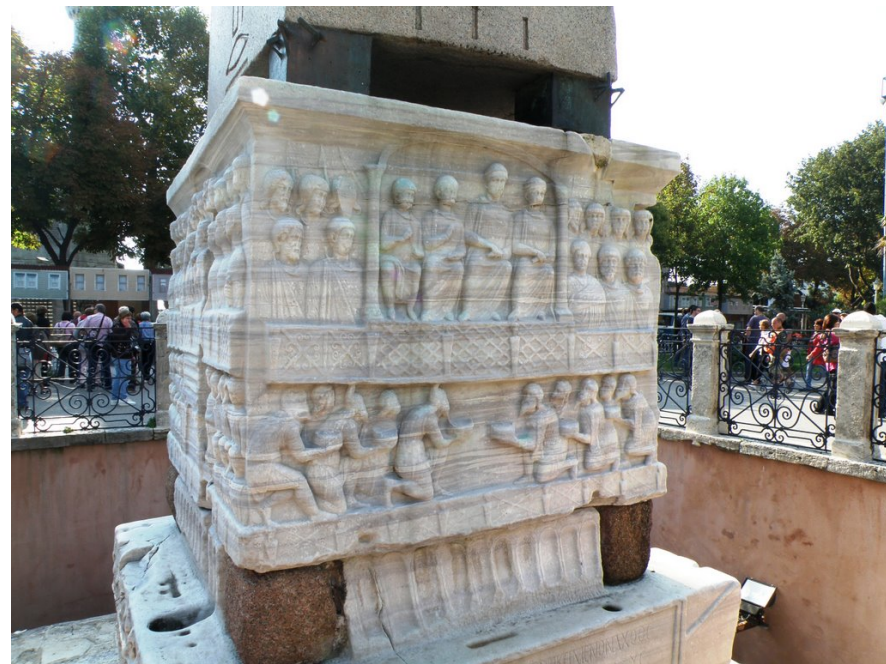
Fig. 2.8 – Dettaglio della base isolata sismicamente dell'obelisco di Dikili Tash o Teodosio, 379-395, Istanbul, Turchia, archivio Panoramio.
