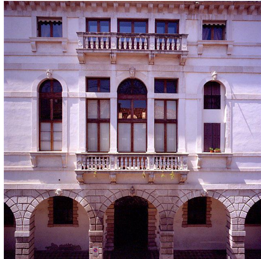
Fig. 4.6 - Palazzo Montalban, fronte principale. Conegliano, Treviso.
