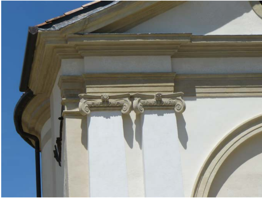
Fig. 5.44 Velatura a tre mani di grassello di calce sulle cornici esistenti e sul timpano.
