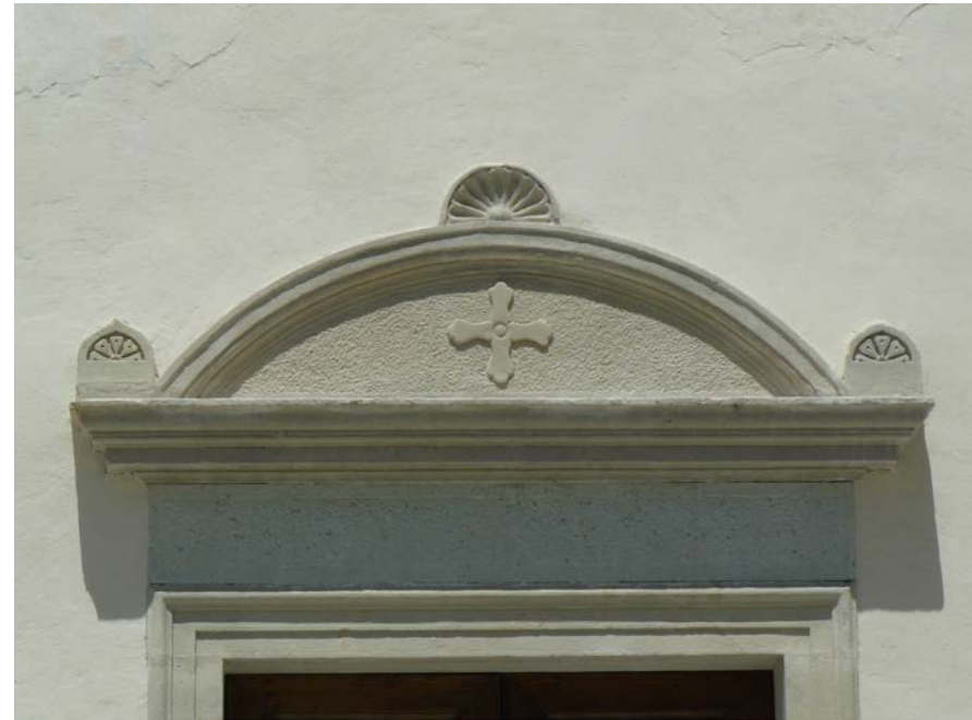
Fig. 5.49 Portale d'ingresso della cappella, pulizia del materiale lapideo e rasatura a grassello di calce e trattamento delle superfici esterne con soluzione a base di ammonio quaternario.
