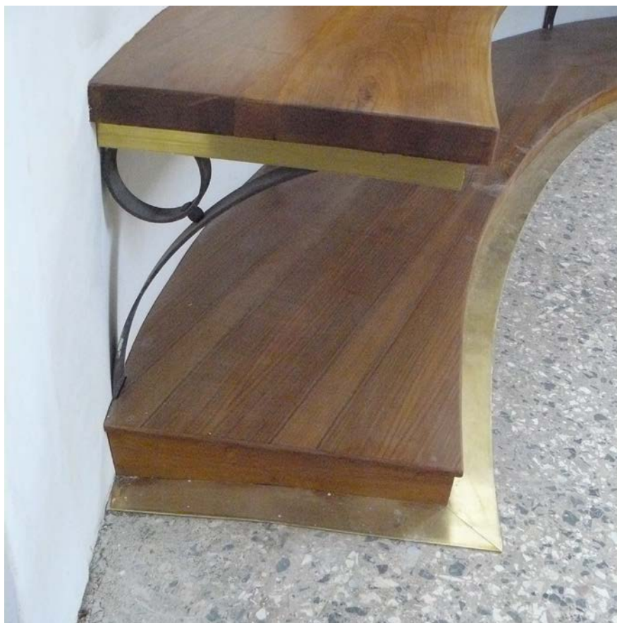
Fig. 5.79 – Base in Larice rosa, a basso spessore, all'interno della quale è stato predisposto il riscaldamento a pavimento.
