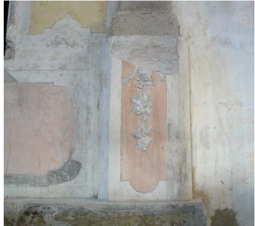
Fig. 5.36 Parziale assenza di decorazione dell'altare della cappella gentilizia.
