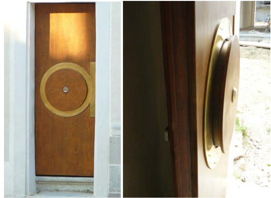
Fig. 5.71-5.72 - Porta d'ingresso secondario della cappella vista d'insieme e dettaglio della particolare apertura circolare.
