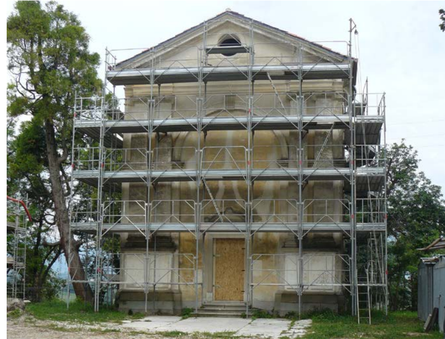
Fig. 5.47 Trattamento biocida con Sali di ammonio e reintegrazioni di microfessurazioni con impasto a base di polvere di marmo.
