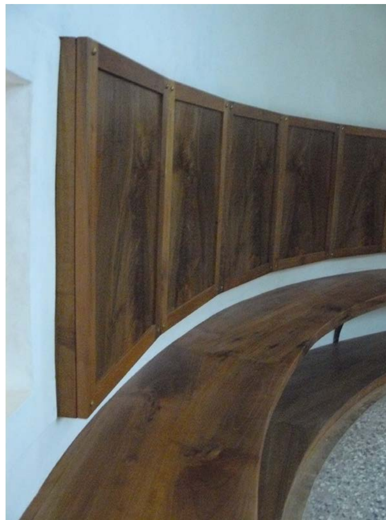
Fig. 5.80 – Quadrettoni dello schienale del coro realizzato il legno di larice rosa a ridotto spesso, all'interno della quale è stato predisposto il riscaldamento a parete.
