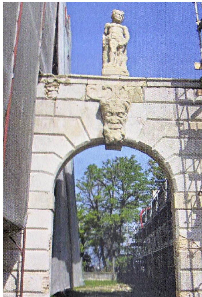
Fig. 4.12 - Fronte principale in cui si può apprezzare la lavorazione a bugnato gentile del loggiato.
