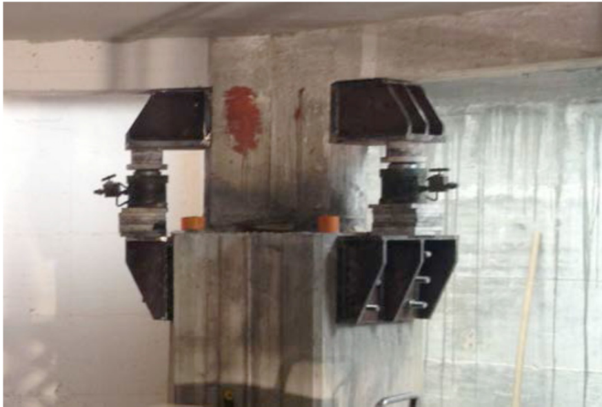
Fig. 6. 29 - Foto di cantiere riferibile alla posa delle mensole e la messa in carico dei martinetti idraulici
