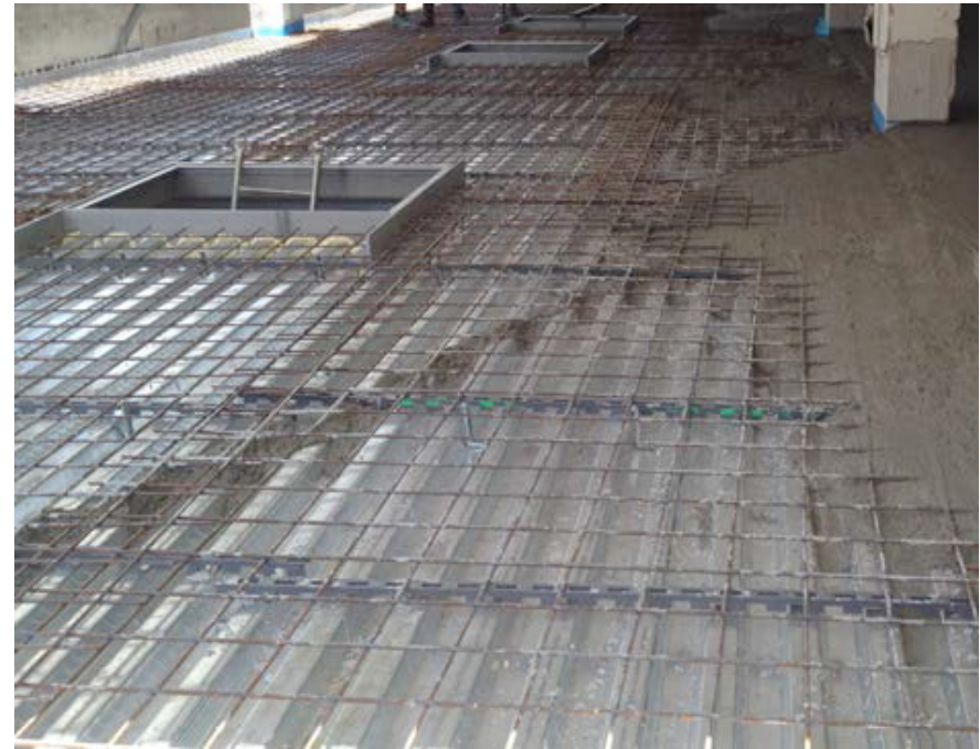
Fig. 6. 25 - Foto di cantiere riferibile al getto del nuovo impalcato
