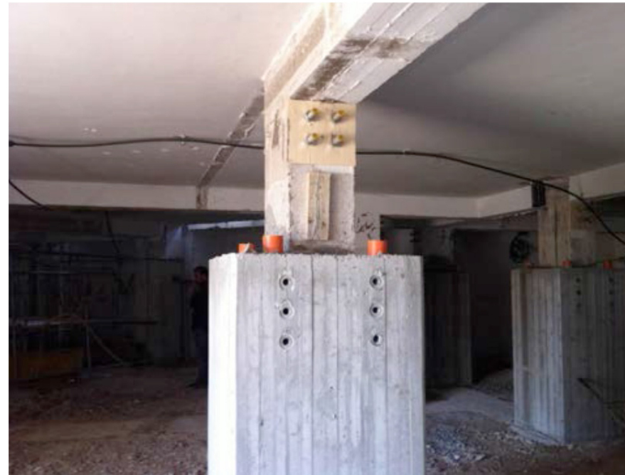
Fig. 6. 28 – Foto di cantiere riferibile al carotaggio e alla predisposizione delle boccole
