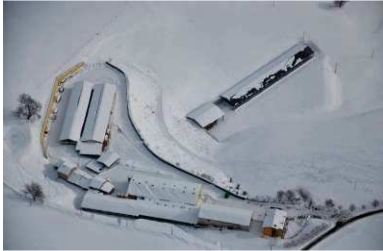
Figura 68: panoramica dell'allevamento: capannone a due piani nel quale vengono allevati i suini (a sinistra) (foto: Chiumenti)
