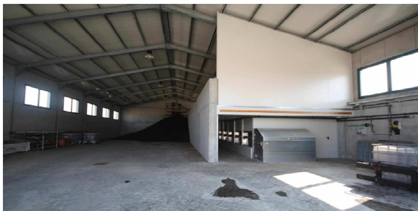
Figura 23: impianto di essiccazione (foto A. Chiumenti)
