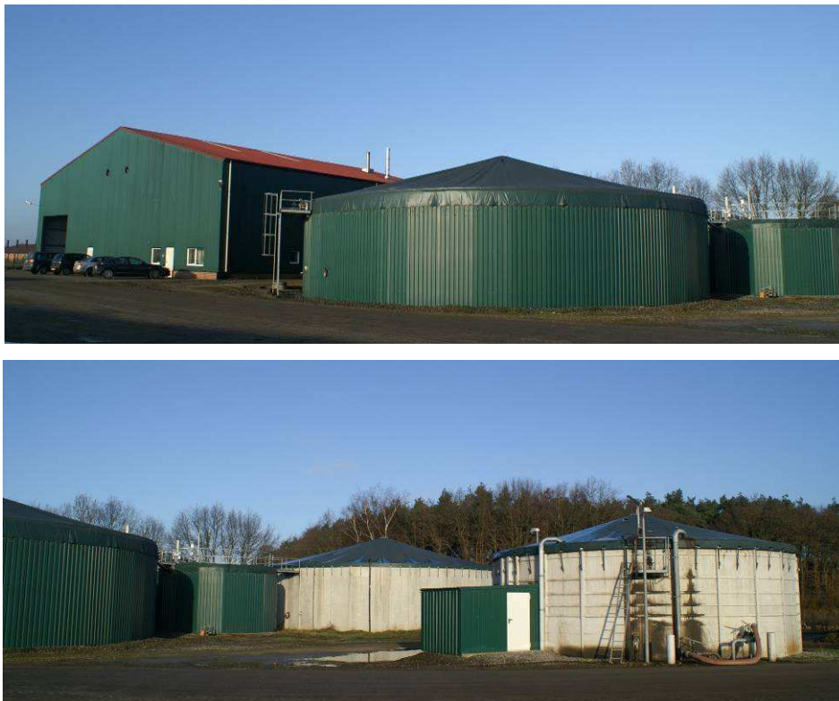
Figura 51: l'impianto di digestione anaerobica sede delle prove sperimentali, sito presso Lastrup, Germania (Foto: A. Chiumenti).
