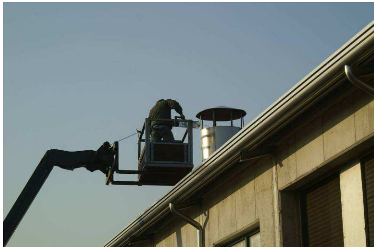
Figura 122: prelievo di aria dall'uscita del camino utilizzando l'aspiratore (Foto: A. Chiumenti).
