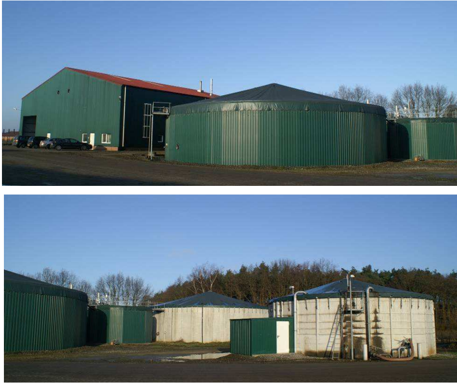
Figura 24: L'impianto di digestione anaerobica sede delle prove sperimentali, sito presso Lastrup, Germania (Foto A. Chiumenti)
