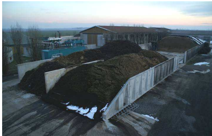
Figura 110: silos orizzontali per le biomasse (Foto: A. Chiumenti).
