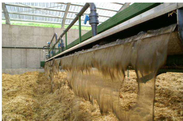
Figura 81: distribuzione dei liquami: in evidenza a sinistra l'apparato di distribuzione a canaletta di tipo centrifugo; a destra l'apparato normale con la classica canaletta. (foto: Chiumenti A.)
