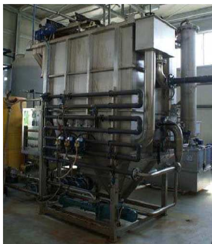
Figura 57: il flottatore della terza fase (Foto:Chiumenti).
