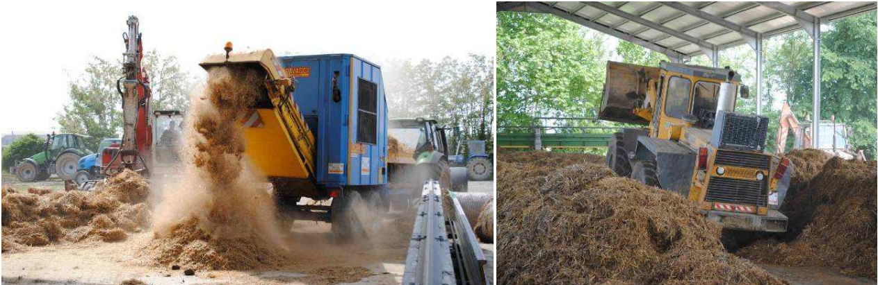
Figura 72: fasi di riempimento della trincea con paglia e stocchi di mais in preparazione del nuovo ciclo.
