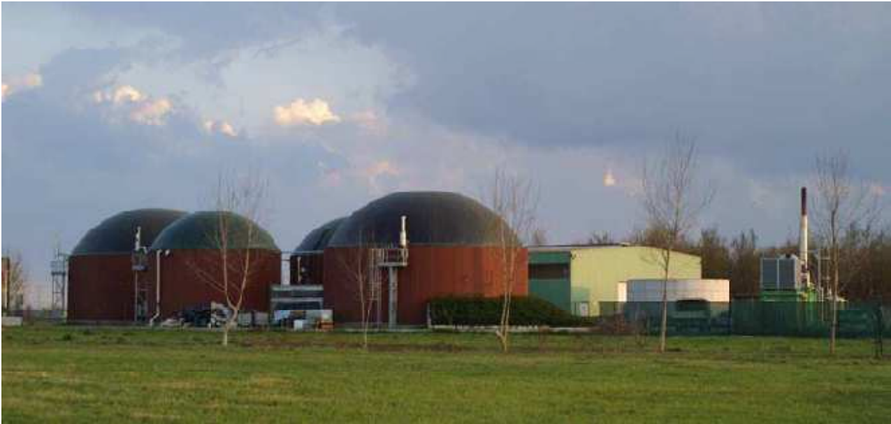
Figura55: panoramica dell'impianto di biogas (Foto: Chiumenti).
