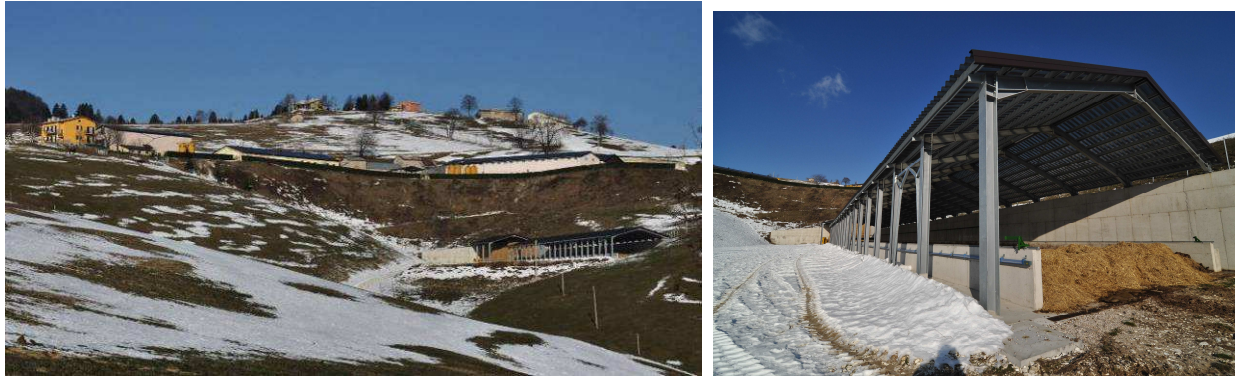
Figura 97: panoramiche dell'impianto nel corso dei mesi invernali.
