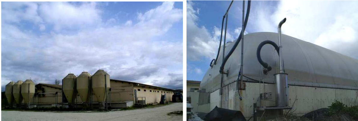
Figura 78: a destra primo piano dell'impianto biogas di tipo plug-flow ; a sinistra vista del complesso zootecnico.
