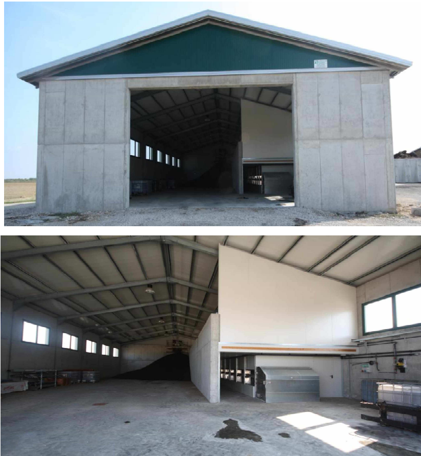
Figura 112: in alto il capannone che ospita l'essiccatoio, sotto l'impianto di essiccazione. In particolare, l'impianto è costituito da tappeti di essiccazione orizzontale, caratterizzati da due livelli di piastre d'acciaio forate di dimensioni 2m x 0,3m che, per la rotazione del tappeto stesso, avanzano in senso inverso e permettono un ottimale passaggio dell'aria. Il tappeto viene mosso tramite sistema di trascinamento a catenaria e la velocità di trasporto è regolabile in funzione alle esigenze e al materiale trattato. La lunghezza utile dell'impianto di essiccazione è pari a 18 m.
