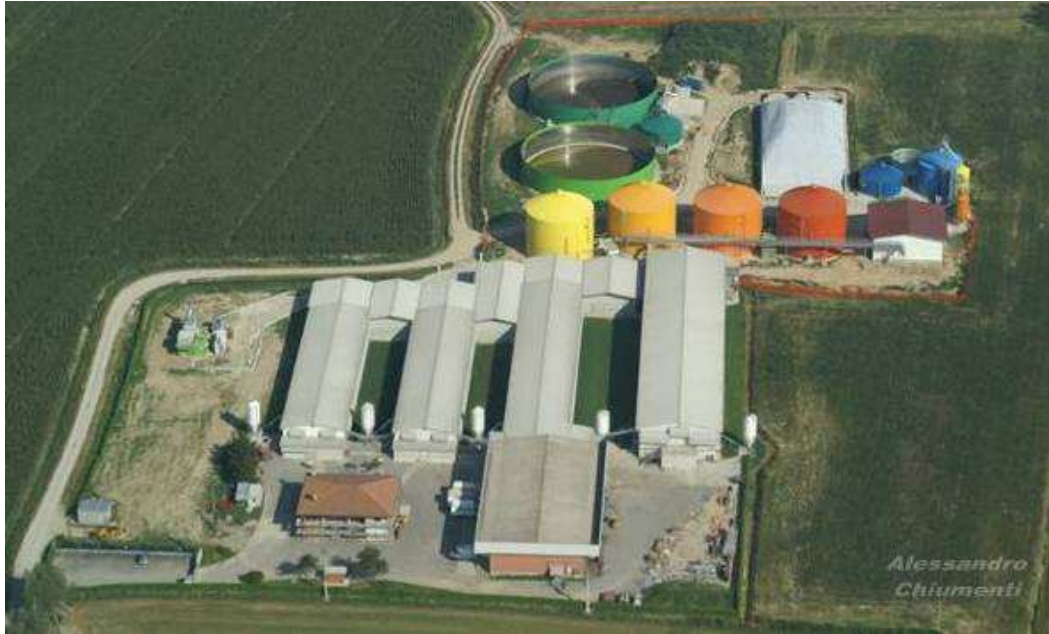
Figura 34: foto aerea dell'allevamento e dell'impianto di biogas (foto: A. Chiumenti).
