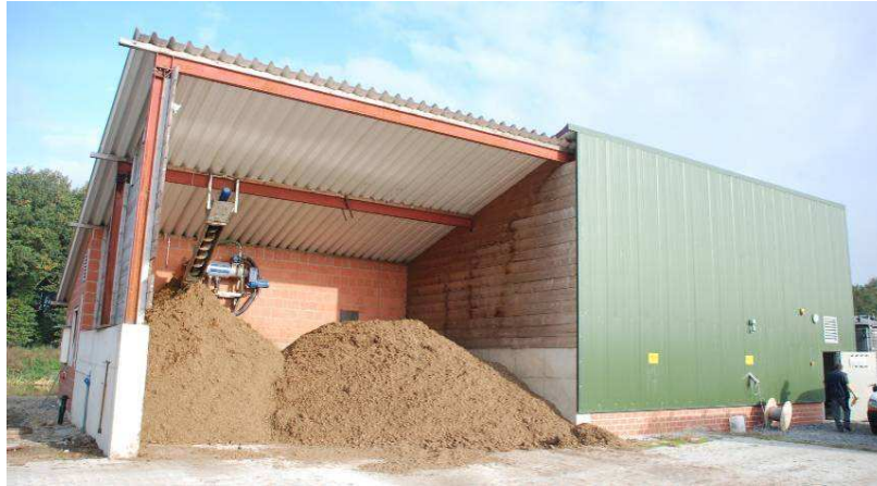
Figura 52: particolare del locale destinato al trattamento del digestato: si possono notare i cumuli dei solidi prodotti dal separatore e della centrifuga (Foto: A. Chiumenti).
