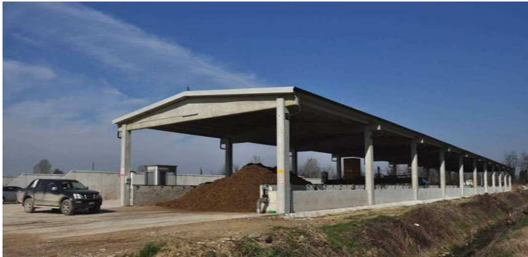
Figura 75: primo piano del capannone di trattamento.
