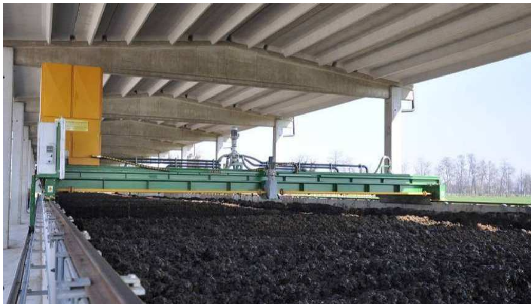
Figura 76: impianto di compostaggio della frazione liquida del digestato, su letto di separato e trucioli.
