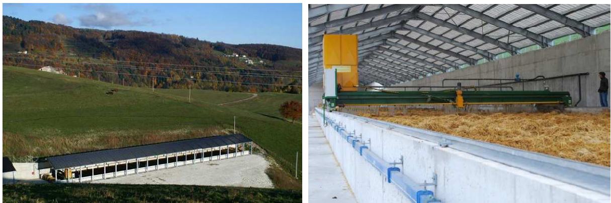
Figura 69: l'impianto di compostaggio (foto: Chiumenti)
