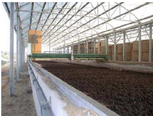
Figura 79: dettaglio dell'impianto di compostaggio (foto: Chiumenti A.)
