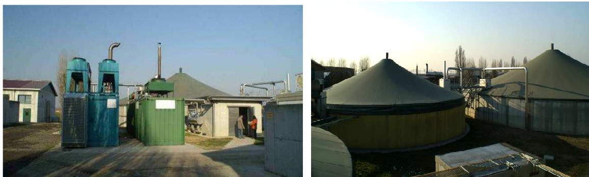
Figura 107: particolari dell'impianto di digestione anaerobica con in evidenza i gruppi di cogenerazione e un fermentatore e lo stoccaggio (Foto A. Chiumenti).
