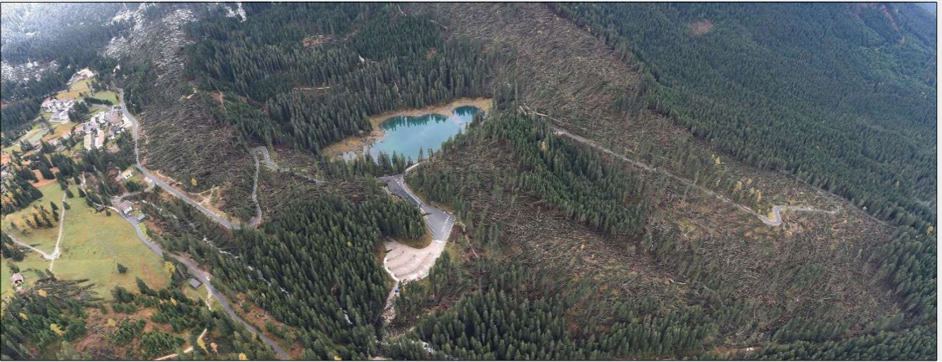
Fig. 4 - Esempio dei danni provocati dalla tempesta Vaia (foto da SAPR in Provincia di Bolzano).
