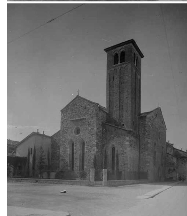
11. Veduta da est, 1938. Le cappelle esistenti lungo il fianco nord sono state ridotte in profondità per consentire l'allargamento della strada.
