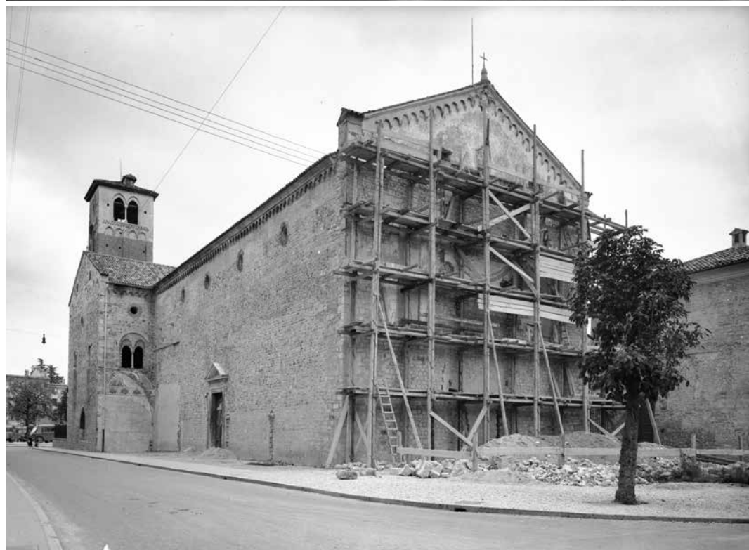
31. La facciata e il fianco nord, giugno 1948. Demolizione del reparto ospedaliero antistante la chiesa.
