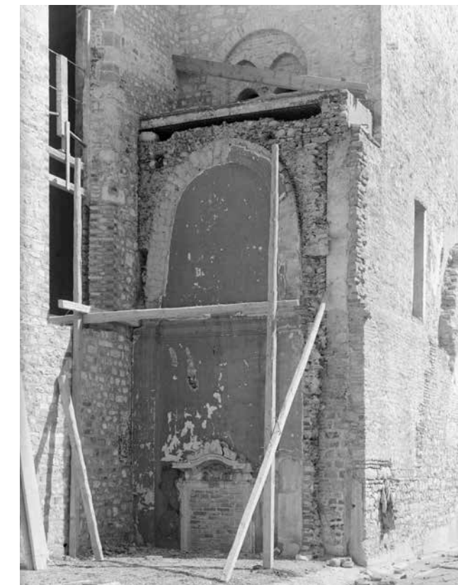
30. Angolo tra braccio destro del transetto e navata, dopo la demolizione della cappelle laterali, settembre 1947.
