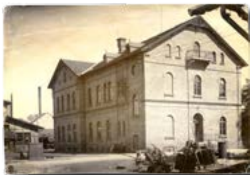
5. Cantiere San Marco a Trieste (1910-1920) Trieste, Fototeca dei Civici Musei di Storia e Arte
