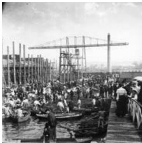
6. Varo presso il cantiere San Marco a Trieste (1910?) Trieste, Fototeca dei Civici Musei di Storia e Arte
