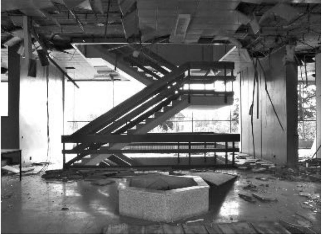
Fig. 05 | La scala autoportante dell'edificio degli uffici nel 2010. La scala risulta essere il fulcro dell'edificio sia dal punto di vista funzionale che da quello compositivo. *Foto degli autori*
